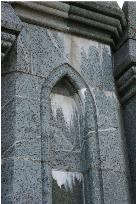
Figur 4 A (venstre) og B (høyre). Ulike reaksjoner med sementmørtel og/ eller bakenforliggende betongkonstruksjon. Til venstre fra det nordvestre tårn på domkirken. Til høyre fra inngangsportalen i Ila kirke. Begge er bygget opp i stein fra Grunnesforekomsten.
