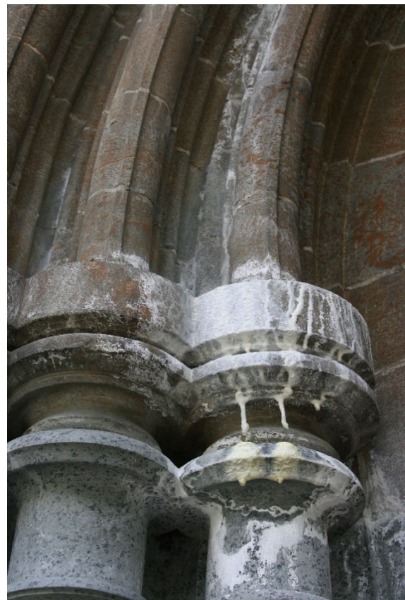
Figur 4 A (venstre) og B (høyre). Ulike reaksjoner med sementmørtel og/ eller bakenforliggende betongkonstruksjon. Til venstre fra det nordvestre tårn på domkirken. Til høyre fra inngangsportalen i Ila kirke. Begge er bygget opp i stein fra Grunnesforekomsten.
