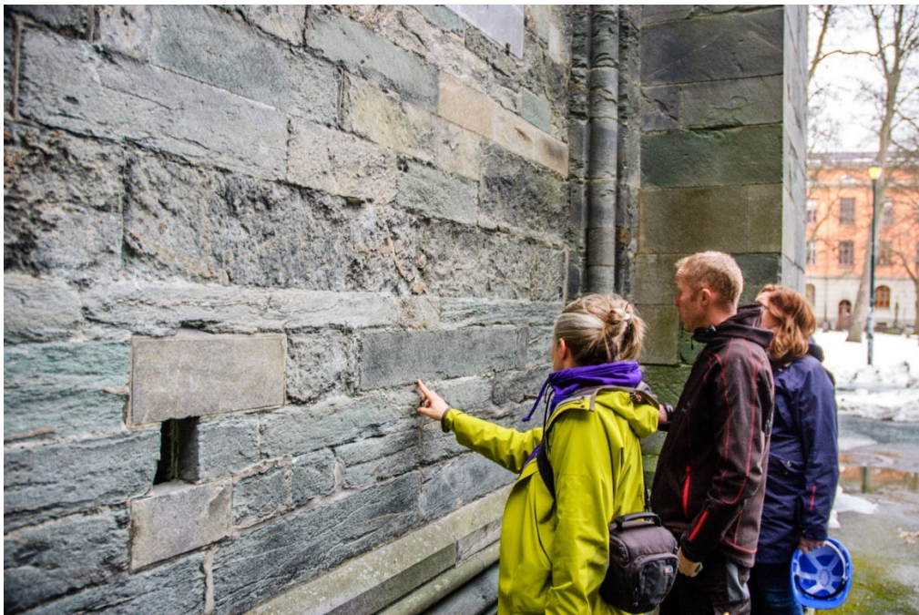
Figur 1. De eldste delene i domkirken er bygget i stein fra Bakkaunet og Klungen/ Øye og ses som grønne blokker med forvitret overflate. Til venstre rundt ventilasjonsluken og mot toppen av bildet ses innfelte stein av svak rødlig kleber fra restaureringsperioden. Det er tydelig at Trondheimskleberen er sterkere forvitret enn disse, men samtidig armeres den av karbonatårene og foliert kloritt og viser brukbare holdbarhet og styrke. Partiet på bildet har vært utsatt for varme og sot fra varmeanlegget som sto i denne delen av kirken. De grønne blokker i nedre delen av bildet er mest sannsynlig klorittskifer fra bruddet på Øye.
