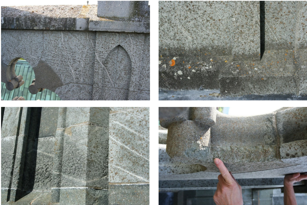
Figur 3. De to øverste bilder viser karakteristisk overflate av kleberstein fra Grunnes som har vært utsatt for vind og vær. Det mest karakteristiske for steintypen er de rustrøde flekker av karbonat med sine mikroskopiske korn av jernoksid som ruster. Ofte danner karbonat en form for lagdeling eller bånding og markante årer av karbonat forekommer hyppig. De nederste bilder viser forvitring i form av avflekking. Begge områder er utsatt for sterk erosjon av vind, men det kan også være mineralogiske variasjoner i steinen som gjør deler av en og samme stein mer utsatt for forvitring enn andre.
