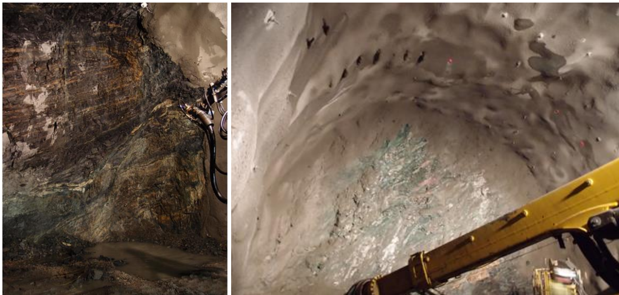
Figur 11: Meget dårlig bergmassekvalitet ved PEL 8305 i vestre tunnel (til venstre) og ved PEL 8339 i østre tunnel (høyre). For sistnevnte er hele stoffen oppsprukket berg med leire og med en grønn sleppeflate på skrå i venstre del.
