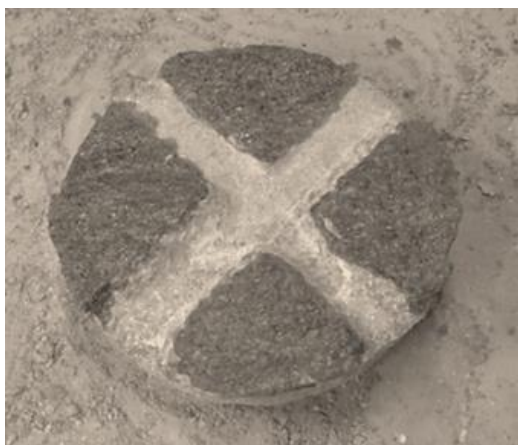
Figur 141. Kryss i steinen som tilpassar nøyaktig til tremalen.
