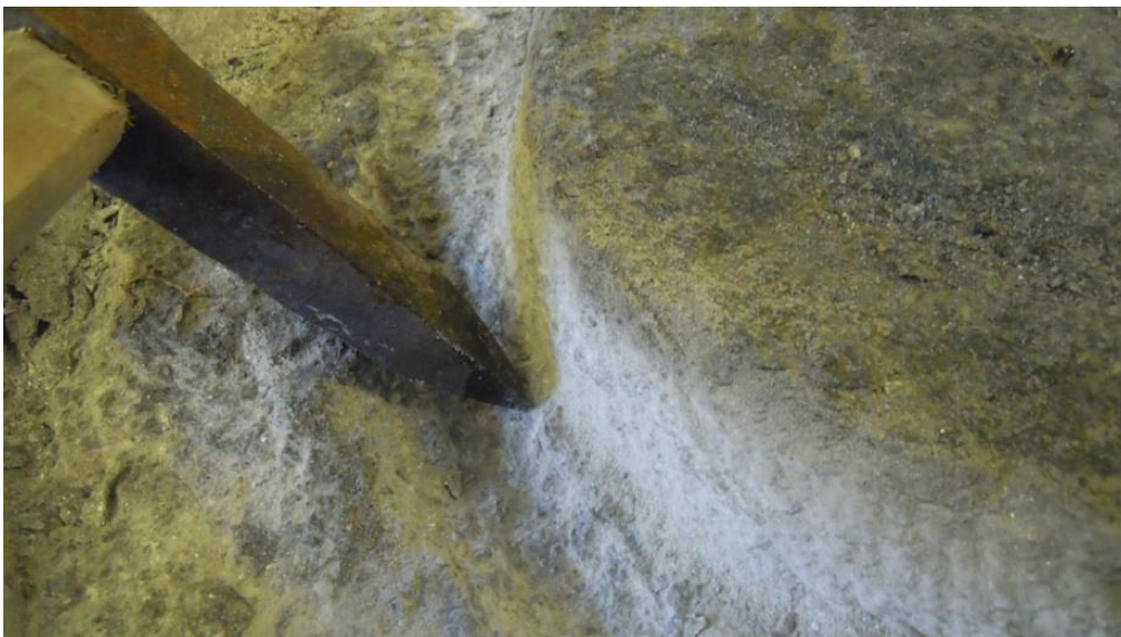
Figur 60. Fjerning av spor etter overgangen mellom hoggeskifta.
