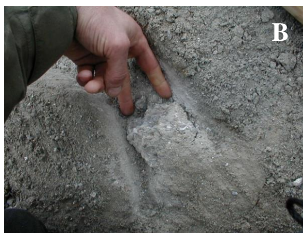
Figur 56. Fjerning av kanalryggen frå enden ved hjelp av hoggjernet.
