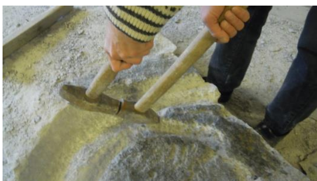
Figur 55. Løysing av kanalryggen frå enden ved hjelp av hammar og sett.
