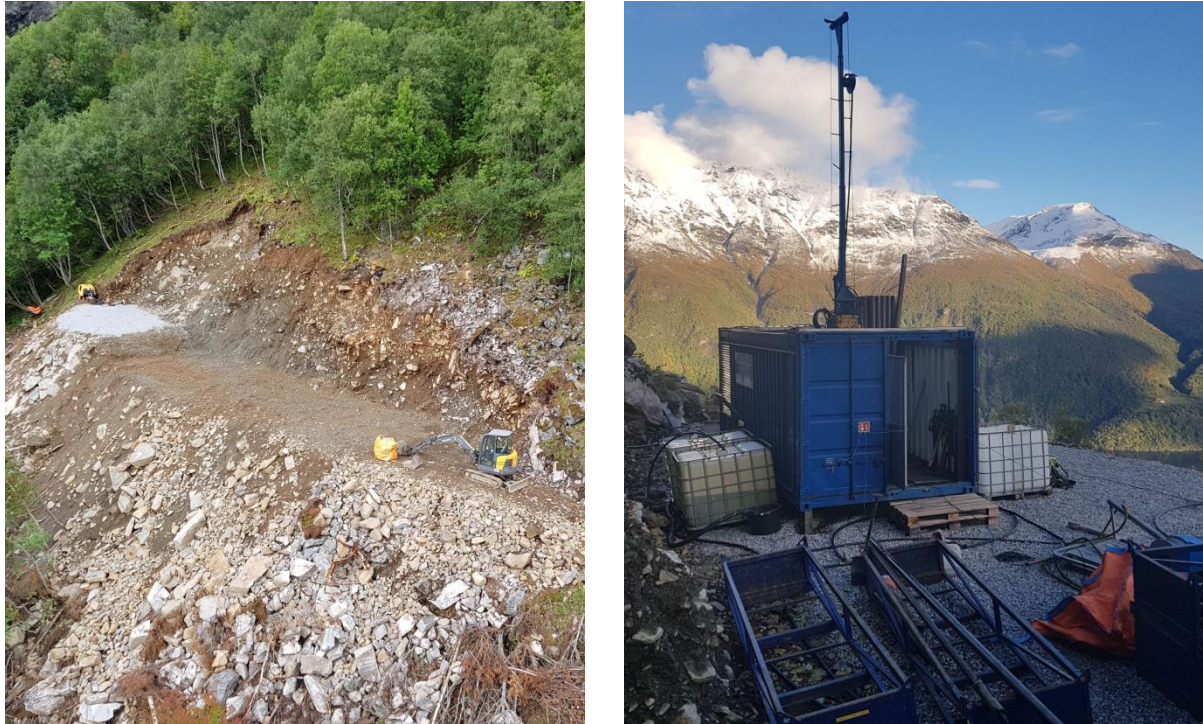
Figur 39. KH-02-18, boreplass med borerigg (Foto: Gustav Pless).
