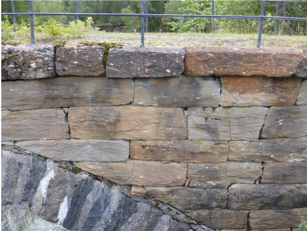
Figur 44: Diamiktitt brukt i brua over Unkerelva.
