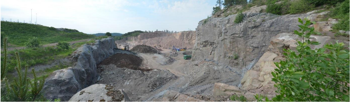
Figur 8: Taranrød pukkverk sett mot sør. Til venstre bak gjerdet ligger avfallsdeponiet Tønsberg fyllplass. I forgrunnen ses oppfylling av dagbruddet med deponimasser.
