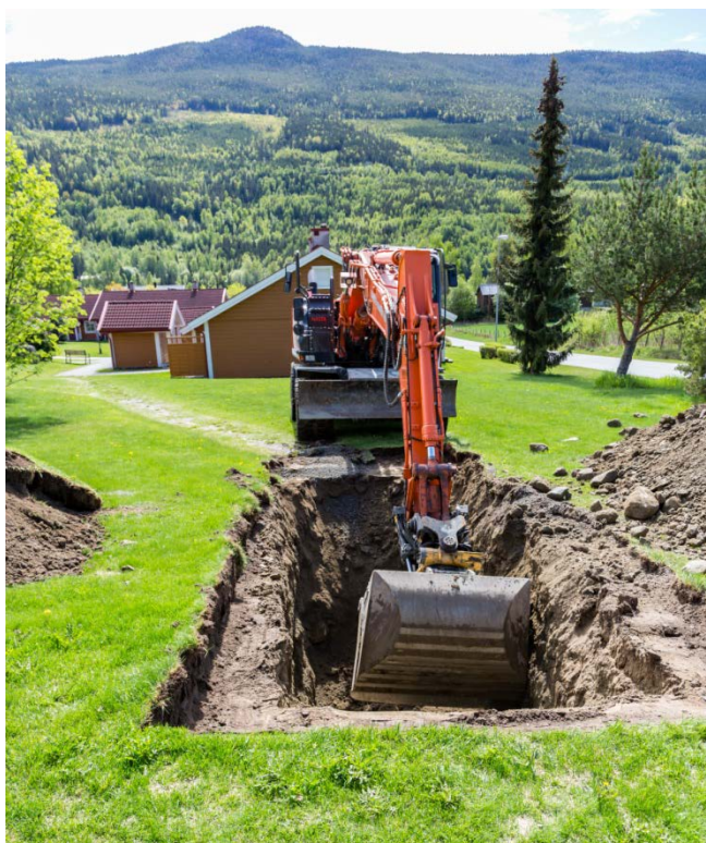
Figur 11. Gravemaskin i arbeid ved lokalitet 2. Gropen ble gravd i nord-sør retning (bildet tatt mot sør).
