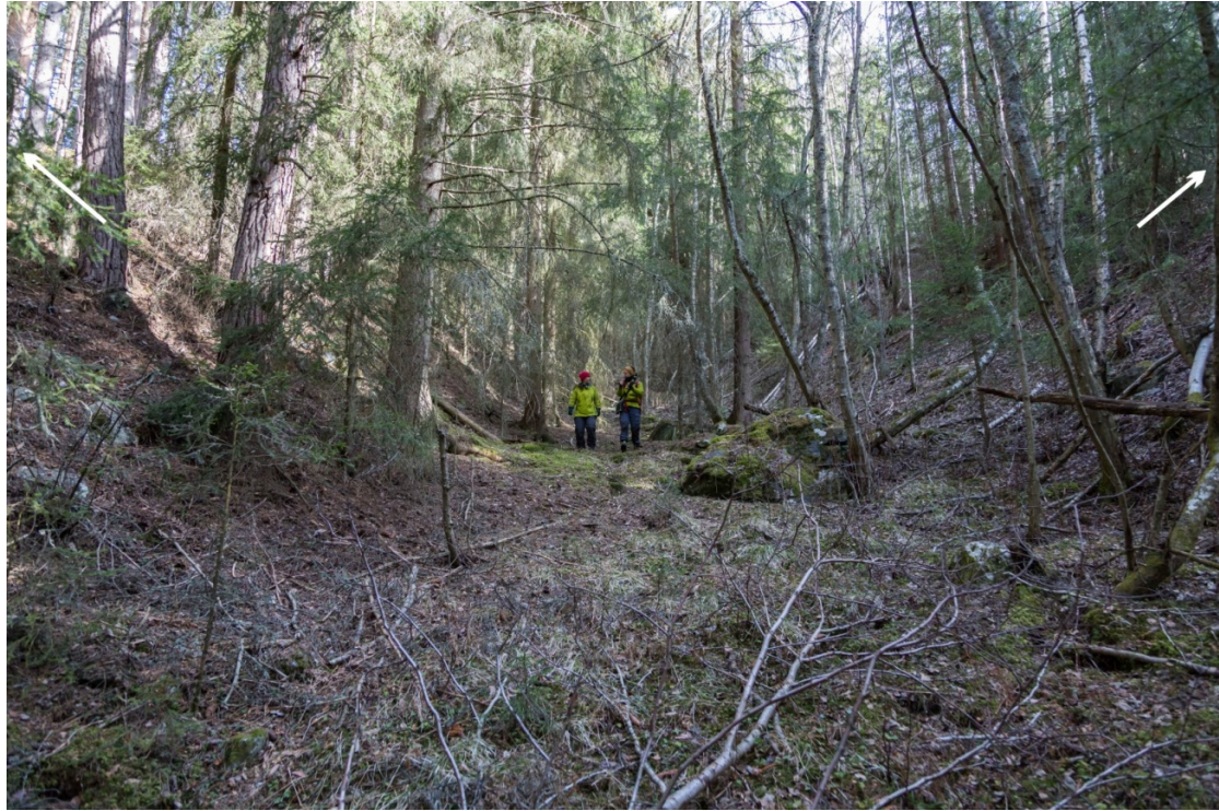
Figur 8. Jord- og flomskredløp ovenfor Tronderudvegen sett oppover (mot nord, se Figur 7). Pilene viser til toppen av kanalen som er ~8m dyp på det meste.
