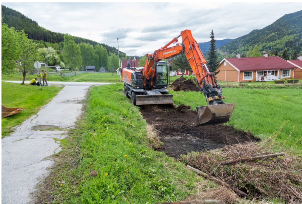
Figur 9. Gravemaskin i arbeid ved lokalitet 1. Georadar profilet 224 (Fig. 3) er målt langs gangstien til venstre i bildet.
