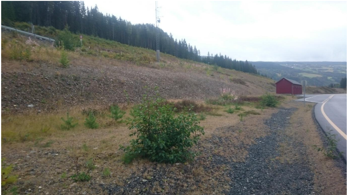
Figur 2. Prøvelokalitet for prøve LH9 ved sørenden av tunnelen på E-6 mellom Tretten og Øyer, hvor mørke skifre fra Brøttumformasjonen er sprengt ut. Lite vegetasjon kan indikere forgiftning av tungmetaller eller forgiftning på grunn av forsuring.
