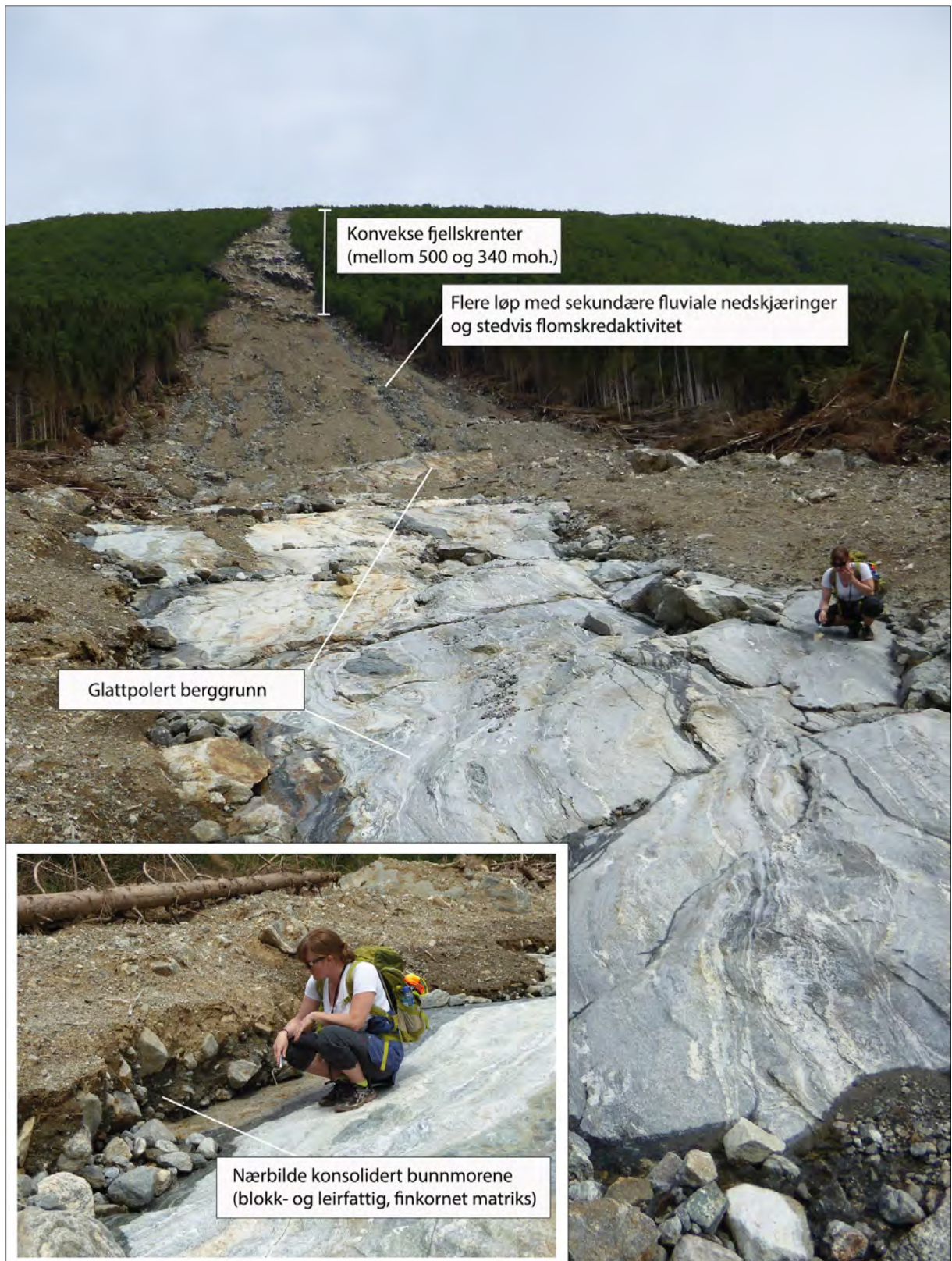
Figur 90: Bilder tatt fra nedre del av skredløpet (120 moh.), hvor det er større områder med glattpolerte, massive fjellblotninger. Dette står i motsetning til fjellhammerne lenger opp i skredløpet, som er oppsprukket og undulerende. Gjennliggende løsmasser er fluivalt, sekundært nedskåret til berggrunnen, hvor det stedvis er tegn etter flomskredaktivitet. Foto: Gro Sandøy, 4. juni 2014.
