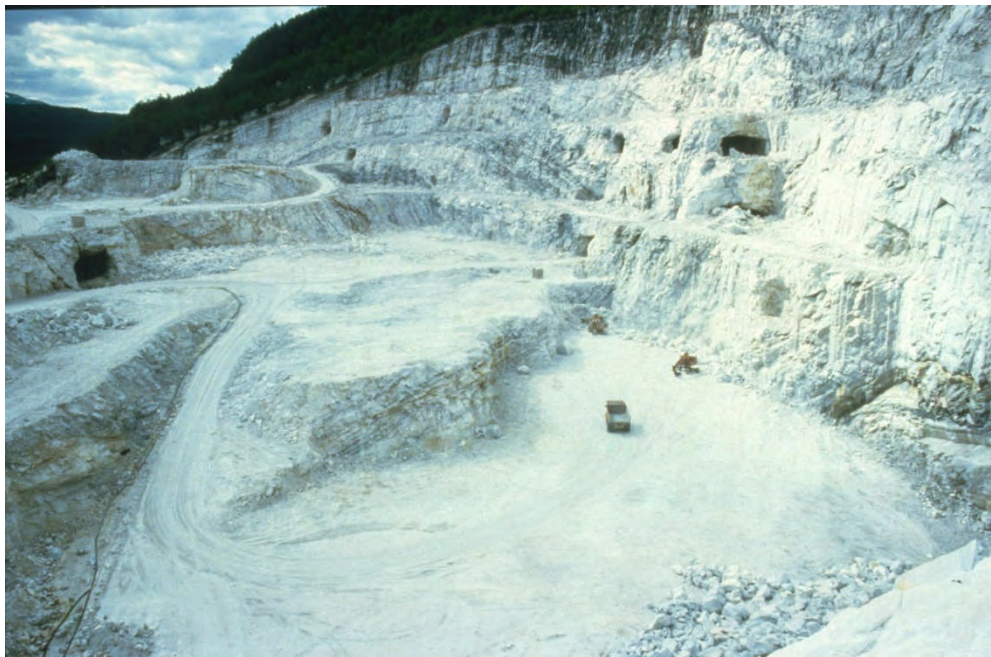
Figur 28. Del av dagbruddet til Hammerfall Dolomitt A/S i 1993, en av tre marmorforekomster som er i drift i Nordland. I dag drives forekomsten som underjordsdrift med nedkjøring fra dagbruddet.
