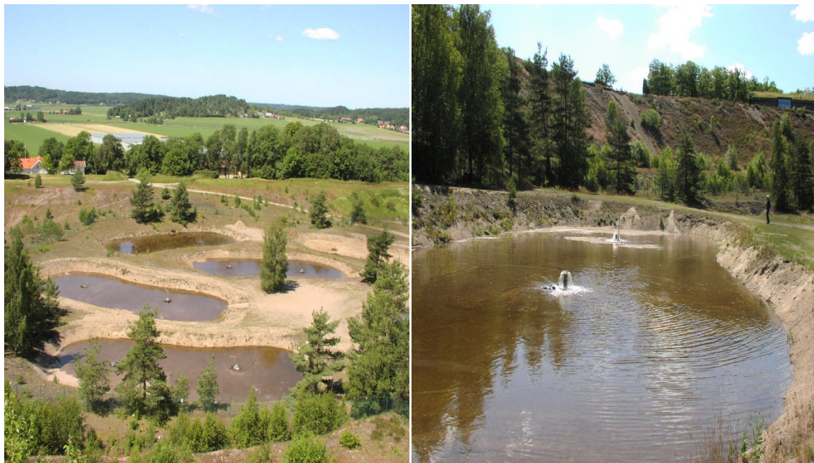
Figur 10 Eksempler på kunstig infiltrasjon av overflatevann i åpne bassenger i Kungsbacka vannverk i Sverige (bilder A. Dagestad)
