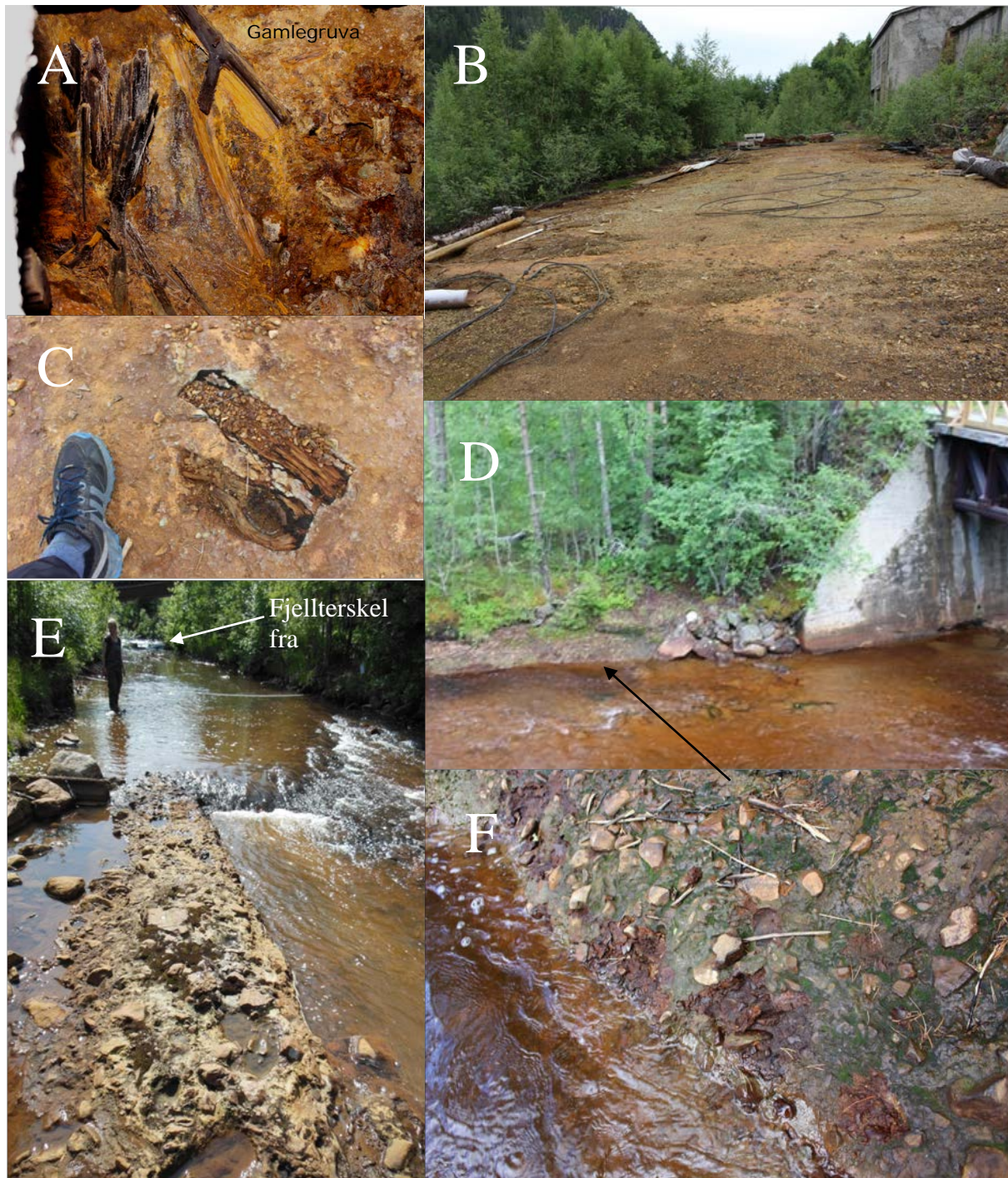
Figur 21: Bilder av jernutfellinger i Løkkenområdet: A: I størrelsesorden 40 meter innenfor åpningen til gammelgruva avslører innstøpt treverk at "fjellveggen" egentlig har sin opprinnelse i lagret gruveavfall som er forstenet, trolig av (jern-)utfellinger. B: Nedenfor synk-flyt-anlegget ser det med første øyekast ut som at berget ligger i dagen. C: Som innfellingen av treverk viser er imidlertid "Berget" i B også forsteinede, planerte løsmasser, trolig også sammenstøpt av utfellinger. D og F: i nedre hjørnet av slamdammen er det også forsteinede masser av elvebunn. E: Forsteinet elvebunn i rød sone av Raubekken ~50 meter nedstrøms fjellterskel vist i Figur 20. Den kan være dannet av a) at grunnvann flommer opp fra sprekker i fjellet, opp gjennom elvebunnen og forsteiner denne i møte med oksygenrikt overflatevann, eller b) som trolig er mest sannsynlig; grunnvann som ble presses opp av fjellterskelen 50 meter oppstrøms i elva feller ut jernet inne i/oppå elvegrusen i møte med oksygenrikt elvevann.
