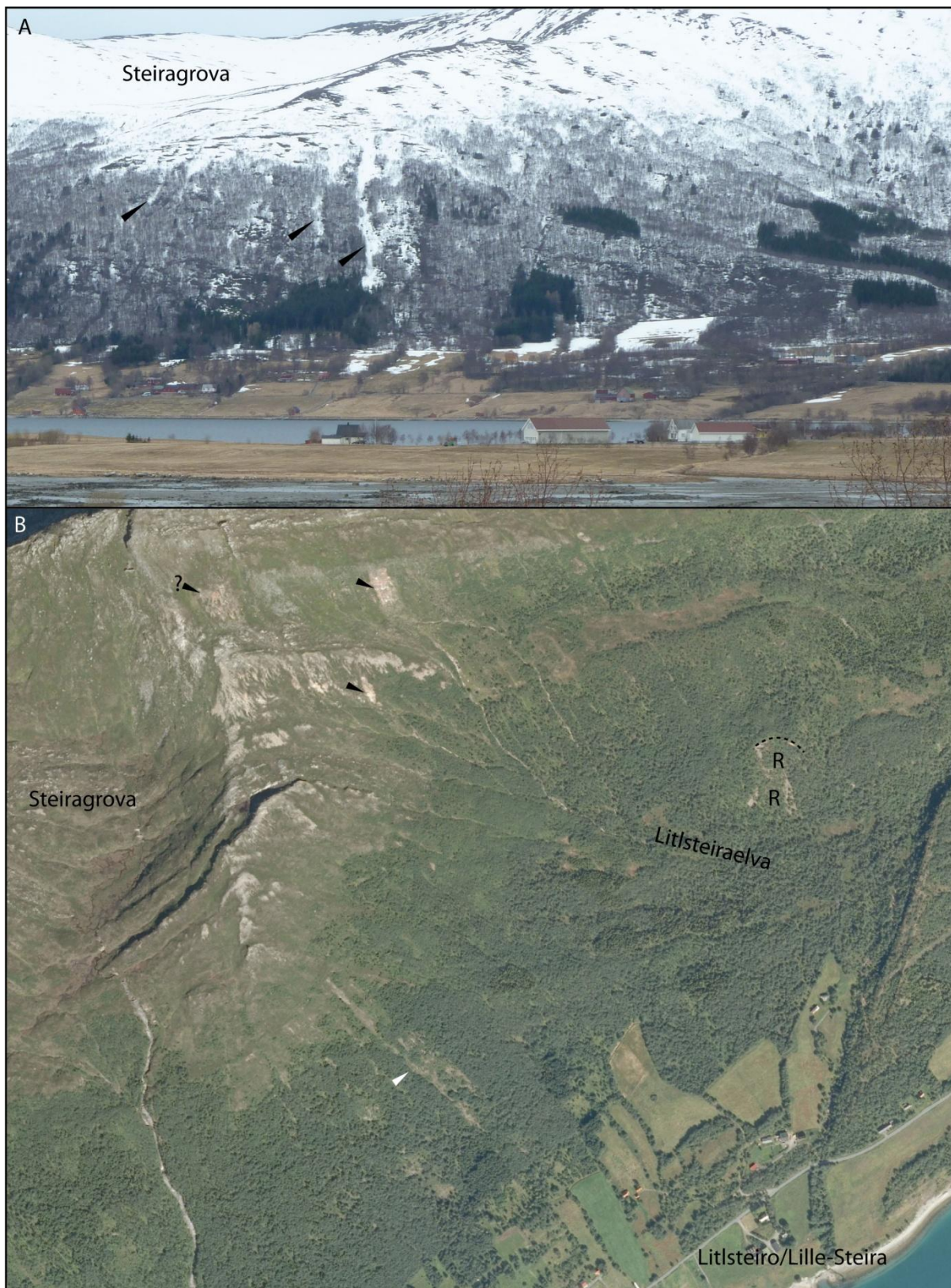
Figur 17. Fjellpartiet nordøst for Steiragrova. A: Tydelige spor etter snø/sørpeskred. Foto: Louise Hansen. B: Ortofoto fra www.norgebilder.no av området nordøst for Steiragrova (se kart i Figur 16 for oversikt). Startområder for jordskred er markert med sorte piler. Jordskredsavsetninger er kartlagt nedenfor (se vedlegg 2). "R" markerer et område der det tilsynelatende er spor etter en (eller flere) skredhendelse(r) ned mot Litlsteiraelva. Den stiplede linjen angir den antatte bakkant av skredet (se tekst). Den hvite pilen angir tydelige spor etter snø/sørpeskred.
