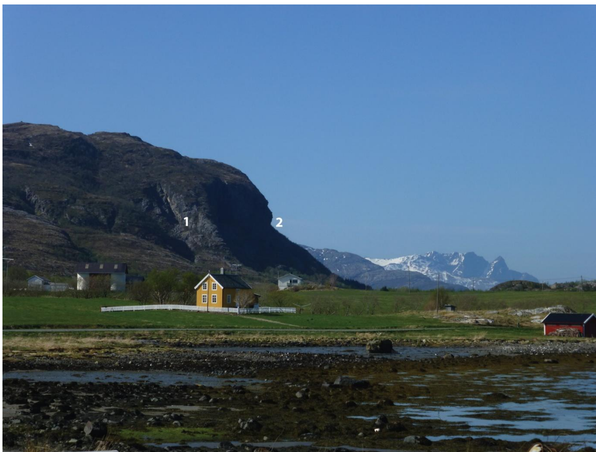
Figur 25. Foto tatt i sørvestlig retning, mot Sandåker på Løkta. Sandåkerfjellet ses til venstre. Legg merke til gjelet med steinsprangsmateriale ved foten (1) og hakket med overheng (2) som begge er plassert over 100 m-nivået (se tekst). Løsmassene i lavlandsområdene karakteriseres mange steder av sandige til steinrike strandsavsetninger. Hav- og fjordavsetninger er vanlig under strandavsetningene. Fjellblotninger stikker frem flere steder (til venstre bak rød bygning). I bakgrunnen ses fjellpartier på Dønna. Foto: Louise Hansen.
