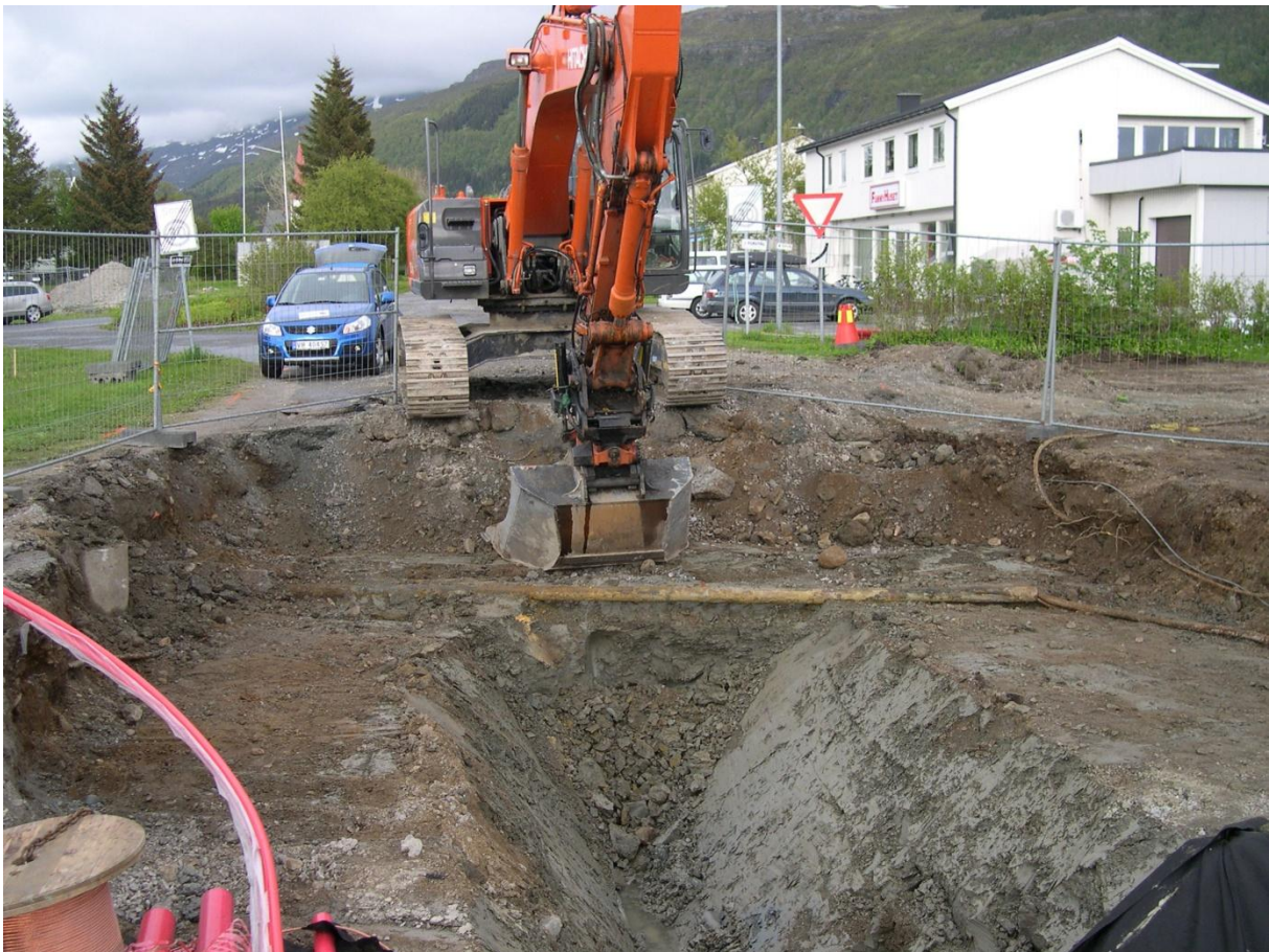
Figur 8. Graving i tørre, siltige leirmasser ved Nesna sentrum. Foto: Harald Sveian.
