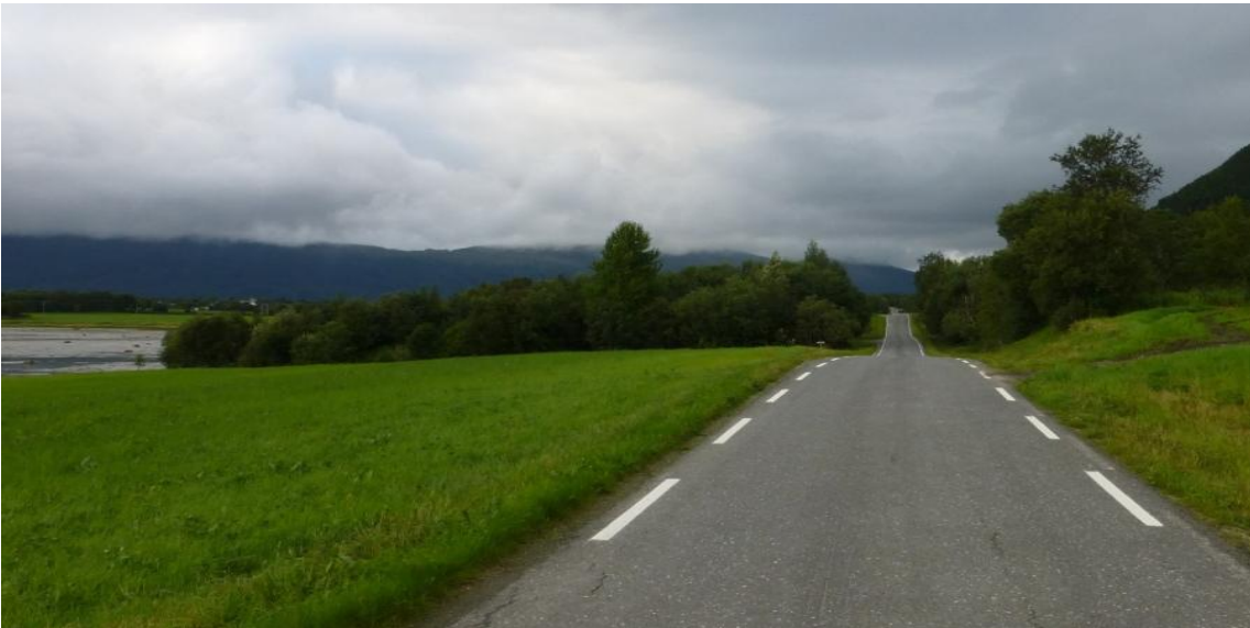
Figur 12. Veien er bygd på tvers av skredgropen (skogkledd forsenkning). Merk tidevannsflaten med blokker og stein til venstre i bildet. Denne flaten er dannet ved langvarig erosjon av bølger og tidevann. Foto: Louise Hansen.
