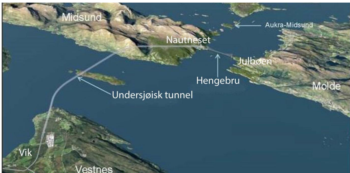
Figur 1: E39 Kryssning av Romsdalsfjorden med hengebru over Julsundet og tunnel under Romsdalsfjorden fra Otrøya til Vik (Kilde: Statens vegvesen Region Midt).
