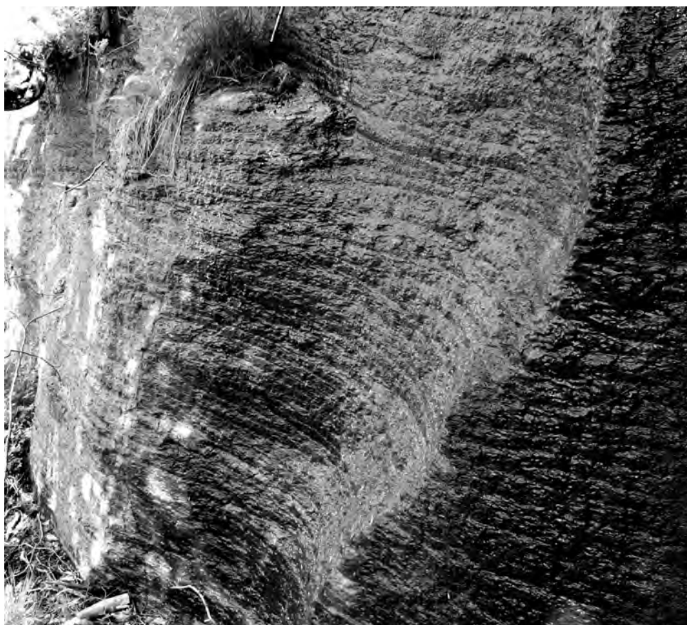
Figur 13. Hogget vegg med horisontale hoggeskift.
