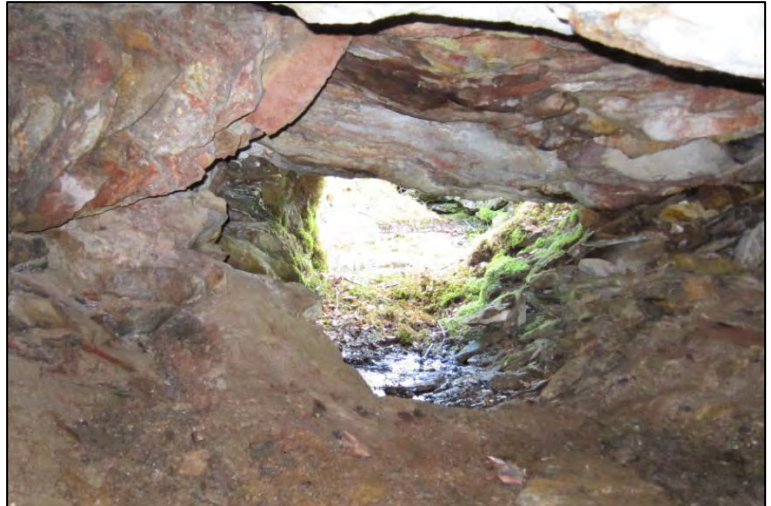
Figur 20. Rødbrent stein i taket i tunnel inn til brudd 012. Foto: Tom Heldal.
