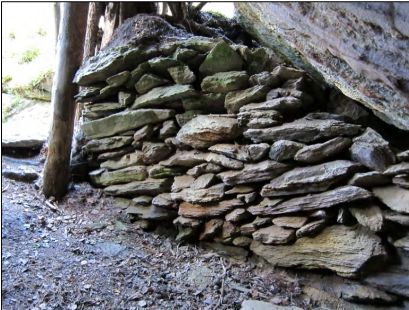
Figur 56. Oppmurt vegg i hula vist i Figur 55.
