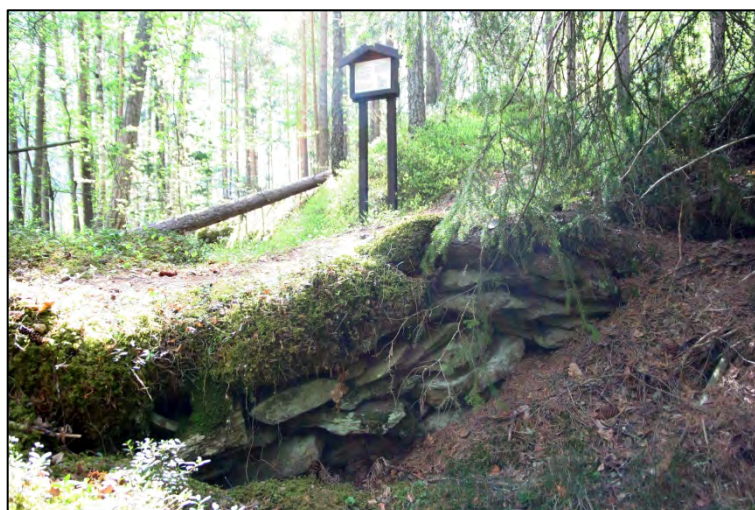
Figur 73. Oppmurt bru til stien over bruddgrop GBM109 , sett mot øst-sørøst.
