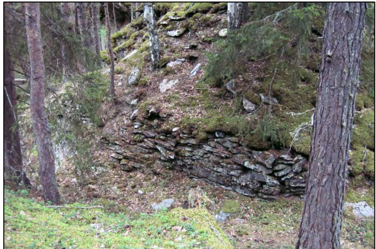
Figur 43. Støttemur på siden av transportvei gravd ut gjennom eldre skrotmasser, Storgruva (sett mot vest-sørvest).
