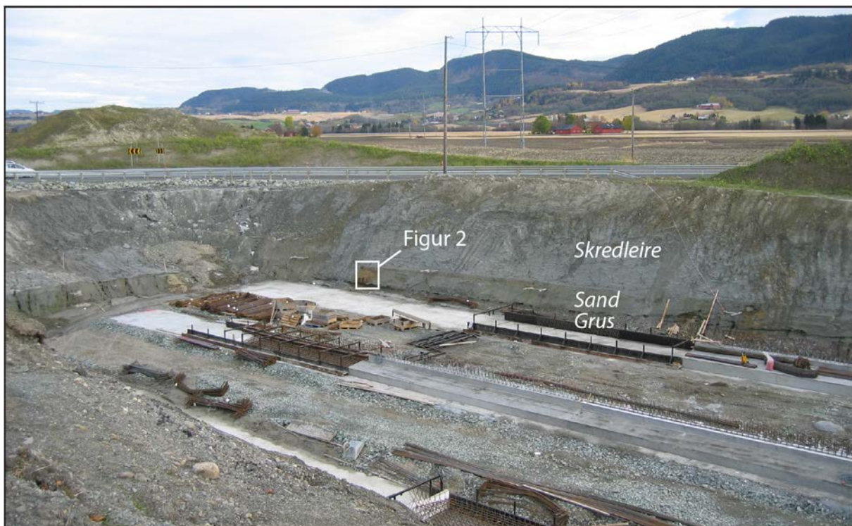
Figur 9. Byggegropp for løsmassetunnel ble laget ved Brubakken i 2004. Se fig. 2 for detalj. Skjæringen viser elvededimenter (sand over grus) i bunnen, med skredleire over (leire med forstyrret lagdeling). Dette korresponderer godt med 2D resistivitetsprofil B1 (Foto: I.L. Solberg).
