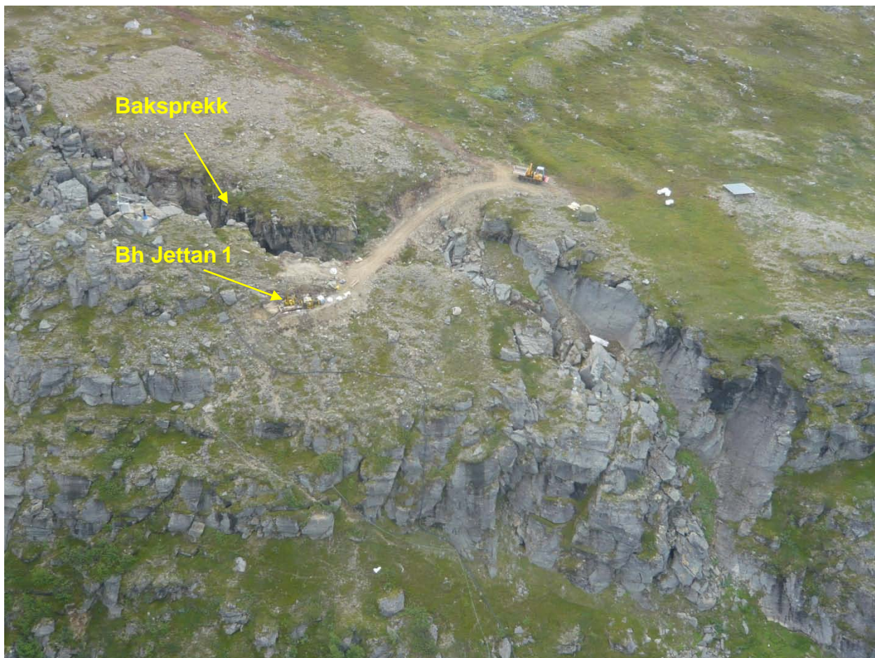
Figur 2. Bilde fra boreplass med baksprekk.
