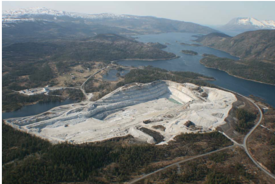
Figur 9: Brønnøy Kalks anlegg i Akselberg forekomsten.
