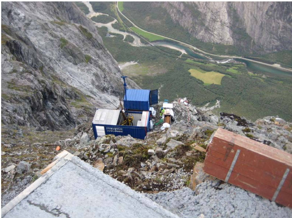
Figur 3. Nedre boreplass, KH-02-11 sett fra helikopterplattform.
