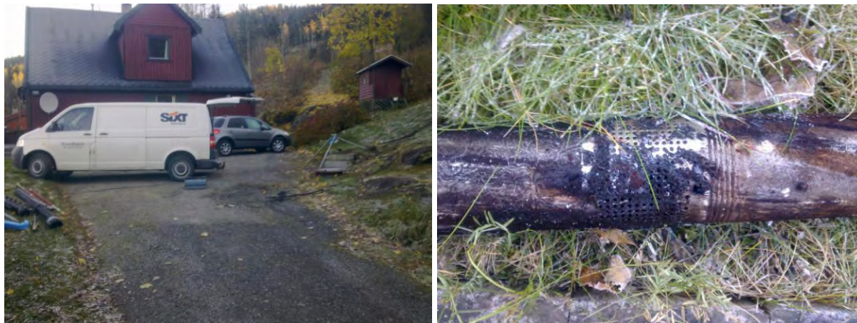
Figur 14. Bilder fra logging i Fb 194-38. Manganutfelling på pumpe (høyre).
