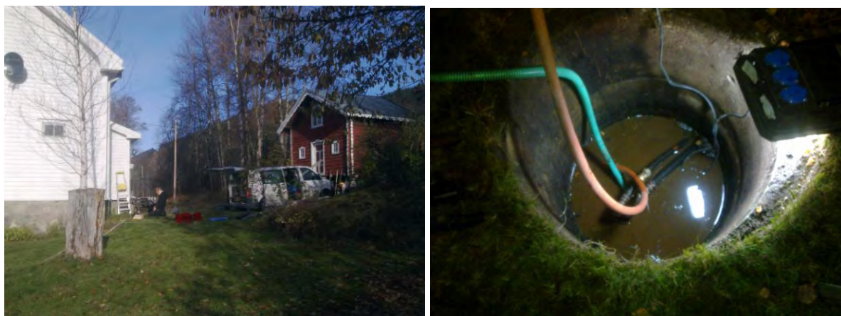
Figur 3. Lokaltet Fb 193-6 (venstre) og pumping av grumset vann (høyre).
