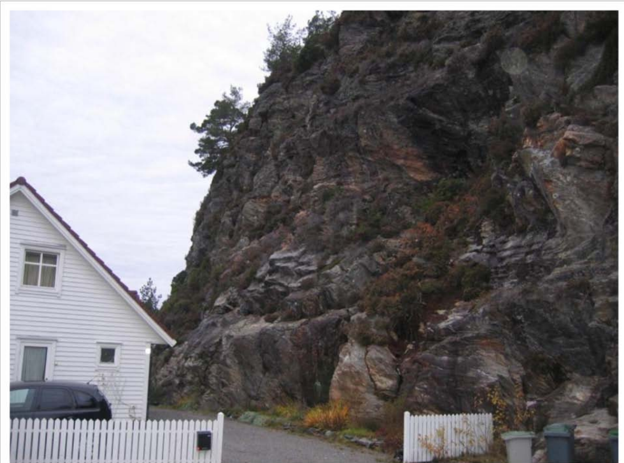
Fig. 9: Svebrotet. Ny bebyggelse innenfor antatt rekkevidde av steinsprang. Sikring med bolter er gjennomført.
