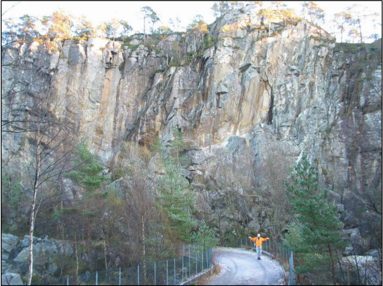
Fig. 13: Langs den gamle vegen ved Kvernavatnet. Personen på bildet markerer maksimum utløp av steinsprangblokker.
