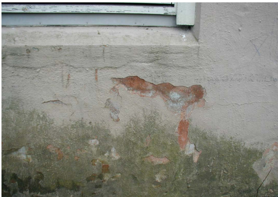
Figur 9: Maling fra vegg kan skrapes løs med tapetkniv (nytt blad for hver ny prøve for å hindre krysskontaminering.
