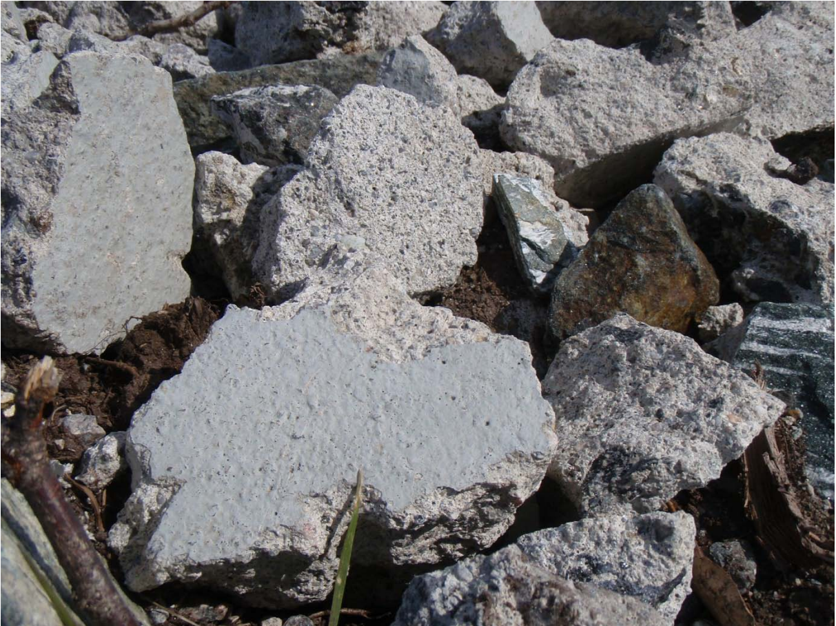
Figur 4: Betong i tippen på Blindheim, Bergen kommune. Her ble det påvist PCB
