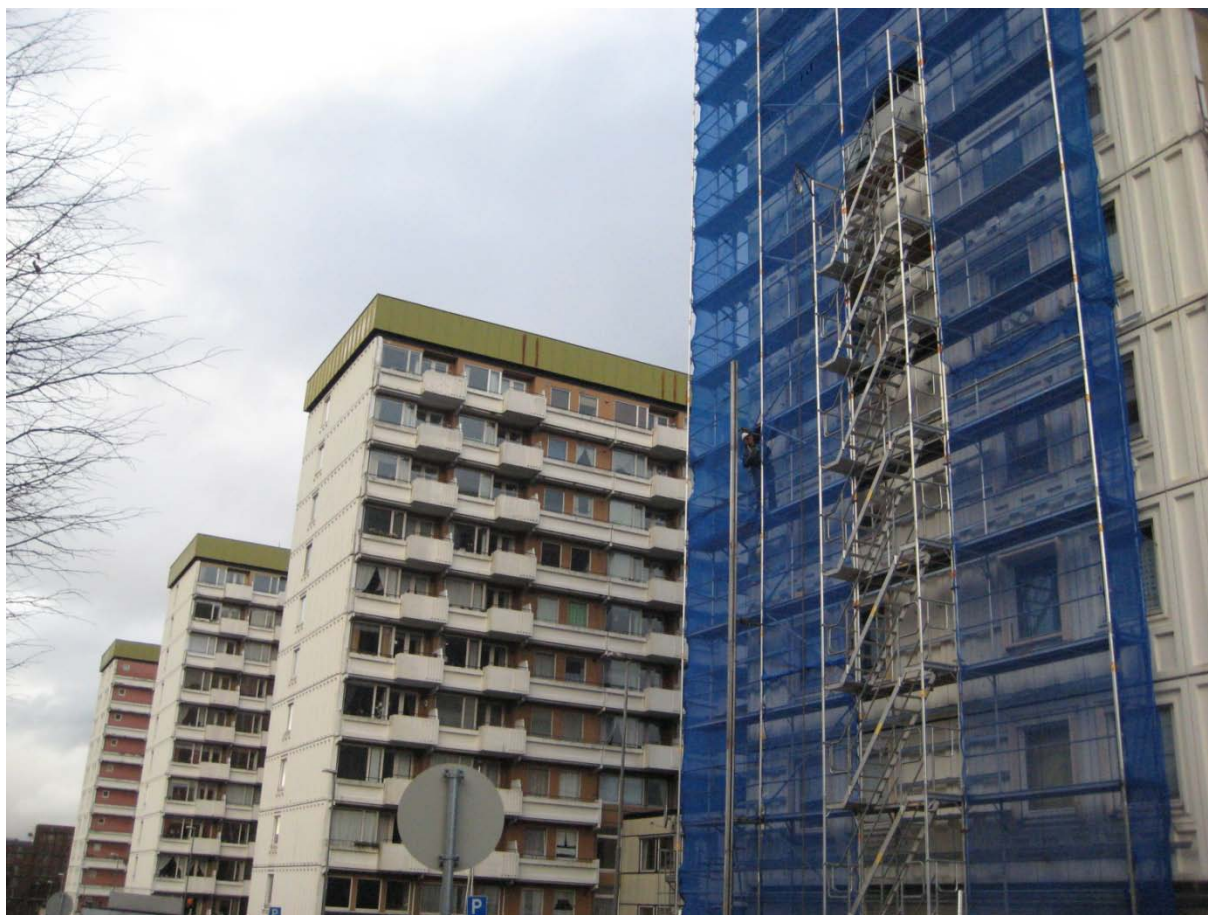
Figur 7: Rehabilitering av Krohnsminde borettslag med utskifting av balkonger med PCB-holdig maling
