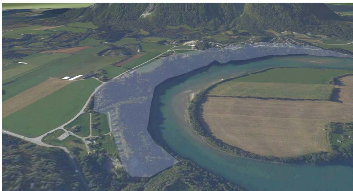
Figur 3-11: Bildet viser den erosjonsutsatte sonen ved Sogge. Fra www.norgei3d.no
