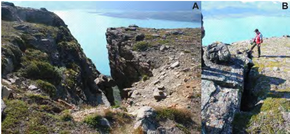
Figur 30: Bilder som viser sprekker relatert til lokaliteten Revdalsfjellet 4.
