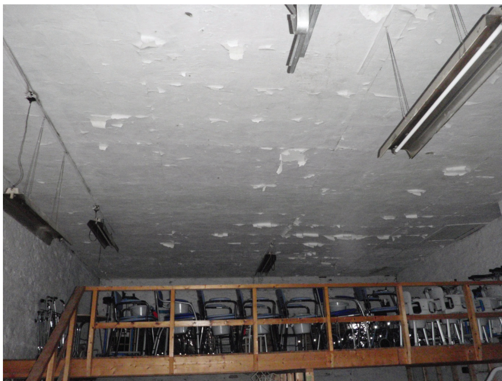
Figur 10: Flassende maling (prøve 41 og 42).
