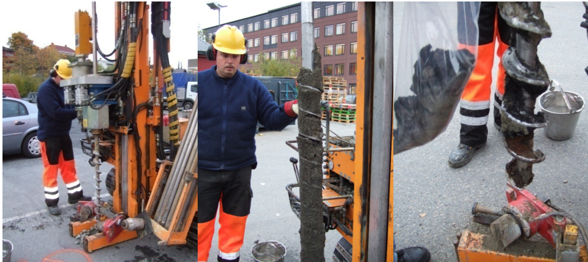
Figur 12: Boring og opptak av løsmasseprøver med skovlbor.
