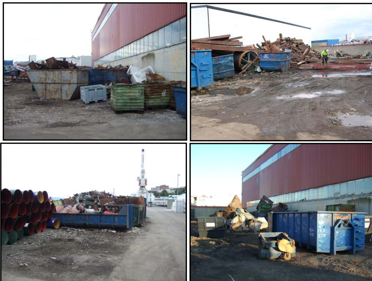
Figur 58 Avfallslager hos Veolia miljø. Lagerplassen har ikke fast dekke. Oljesøl og avfallsfragmenter er lett synlig. Det øverste jordlaget er markert forurenset med metaller, PAH og PCB.
