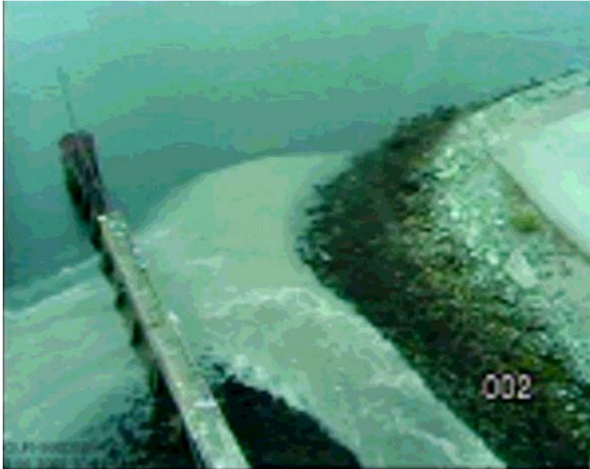
Figur 7 Overløp gjennom Ladebekken . Det partikkelrike vannet ledes her inn i Nyhavnabassenget.
