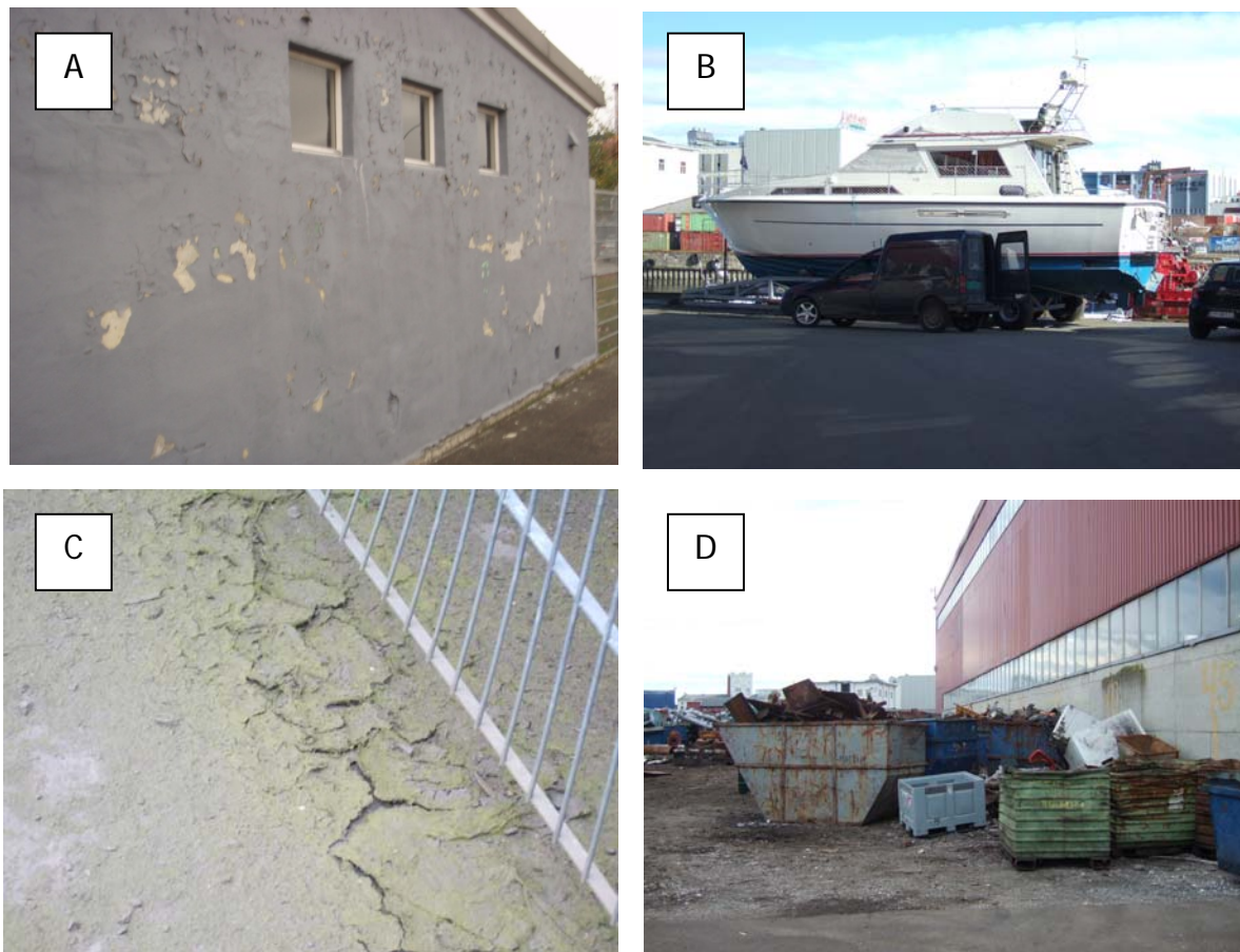
Figur 2 Mulige aktive forurensningskilder a: forvitring av husfasader, b: fjerning av bunnstoff på småbåter, c: sandblåsing av metall og d: håndtering av avfall.
