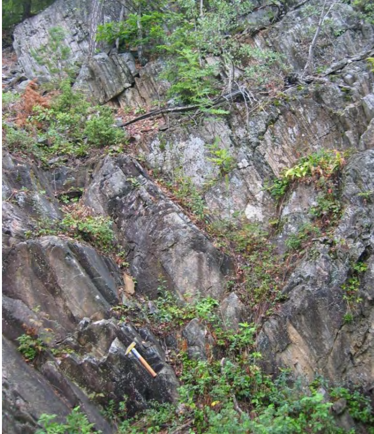
Figur 11 a: Typisk veiskjæring langs skogsbilveien ved umiddelbart SV for Lundereidshølen av sterkt planfoliert migmatittisk granat-biotittgneis (pelitt) med tynne, lyse migmatittiske bånd og tynne, mørke lag av amfibolitt.
