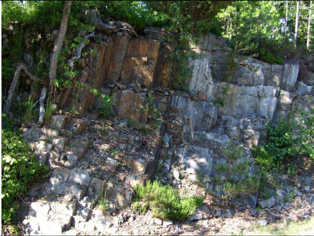
Figur 19: Sterkt deformert, båndet og planskifrig granittisk gneis Veiskjæring ved skogsveien inn til Krok vann.
