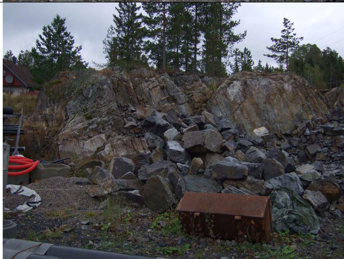
Figur 25 a: Bilde tatt mot øst av skjæring ved Gjerdemyr. Planskifrig grå gneis med hyppige bånd av mørk amfibolitt. b: Bilde tatt mot øst av skjæring ved Gjerdemyr. Godt utviklet planskifrihet i grå gneis.
