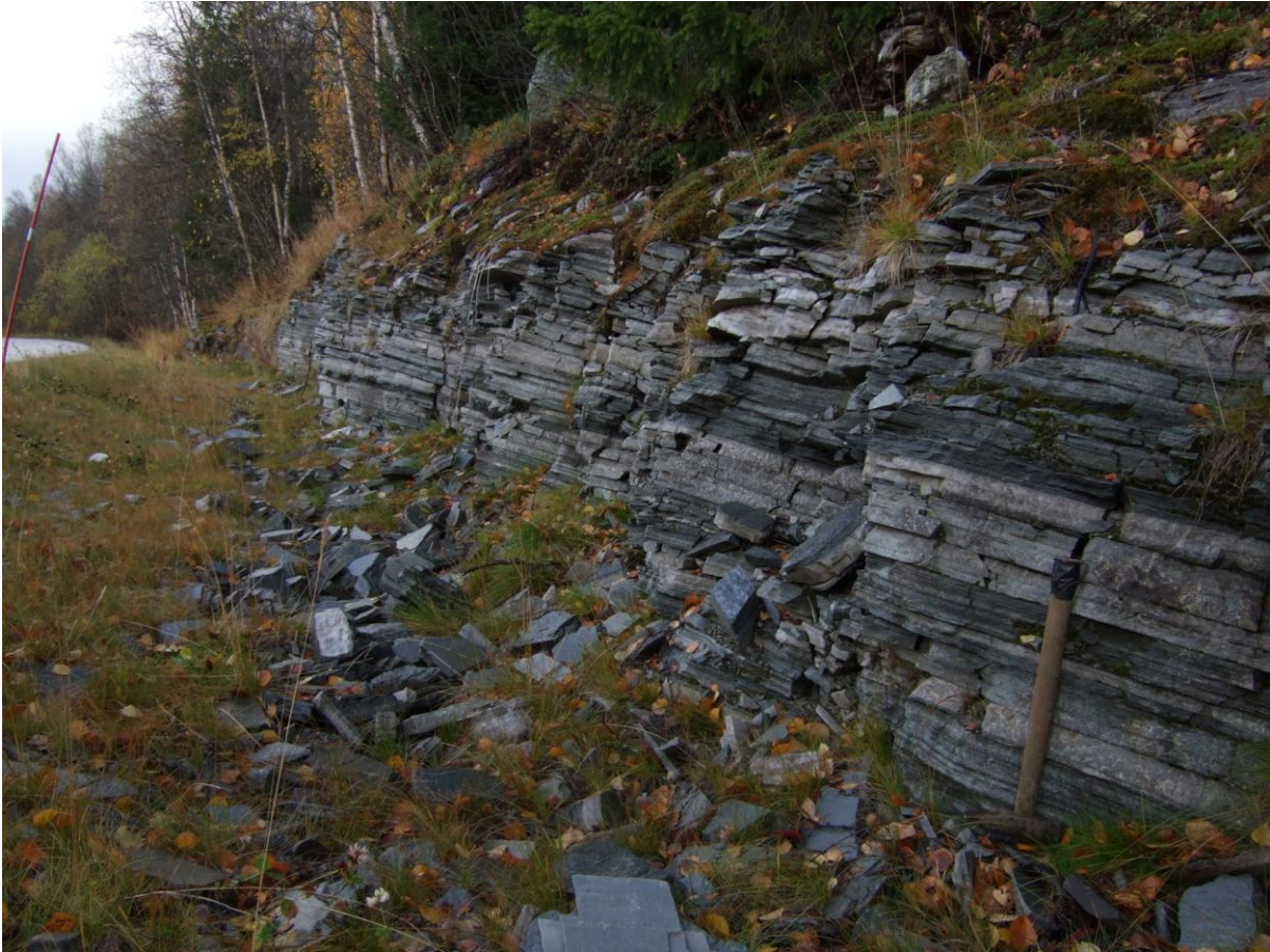
Figur 16: Veiskjæring ved fylkesveien som viser bånding og spaltbarhet på 3-10 cm skala. Bilde tatt mot vest.
