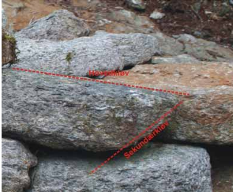
Figur 3-7. Hovedkløv og sekundærkløv i vraket kvernsteinsemne. Emnet har sprukket langs sekundærkløven.
