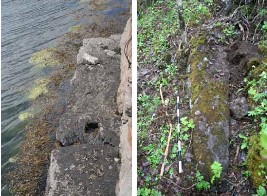
Figur 5-6. Venstre: Stor rektangulær helle med firkantet forankringshull, her resirkulert i moderne brygge. Høyre: Bauta-liknende, hugget stein (Rønset).
