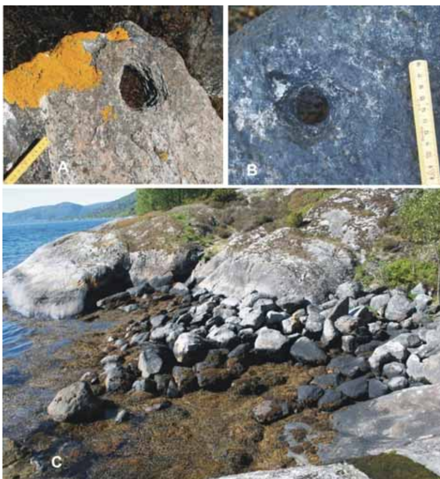
Figur 7-5. A) Hugget båtfeste, B) boret båtfeste, C) mulige rester etter kai.
