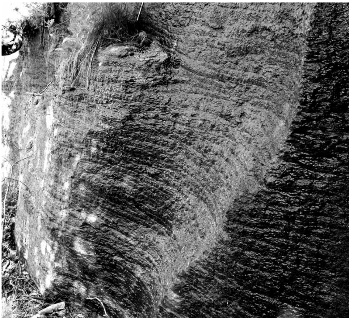
Figur 4-4. Eksempel på hugget vegg med horisontale skift, Myklebust.
