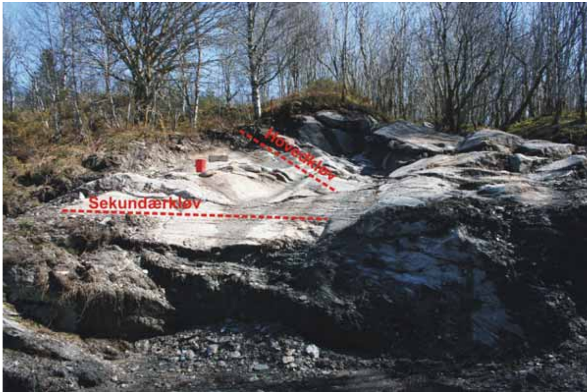
Figur 3-5. Forholdet mellom hoved- og sekundærkløv i testbrudd like ved Kvernsteinsparken. I den nedre del dominerer sekundærkløven fullstendig over den relikte hovedkløven.
