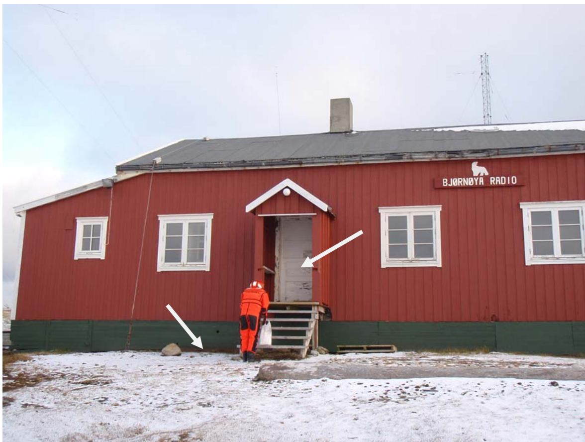
Figur 3: Det ble påvist PCB i malingen på den hvite ytterdøra og i overflatejorda nedenfor ytterveggen på dette bygget.
