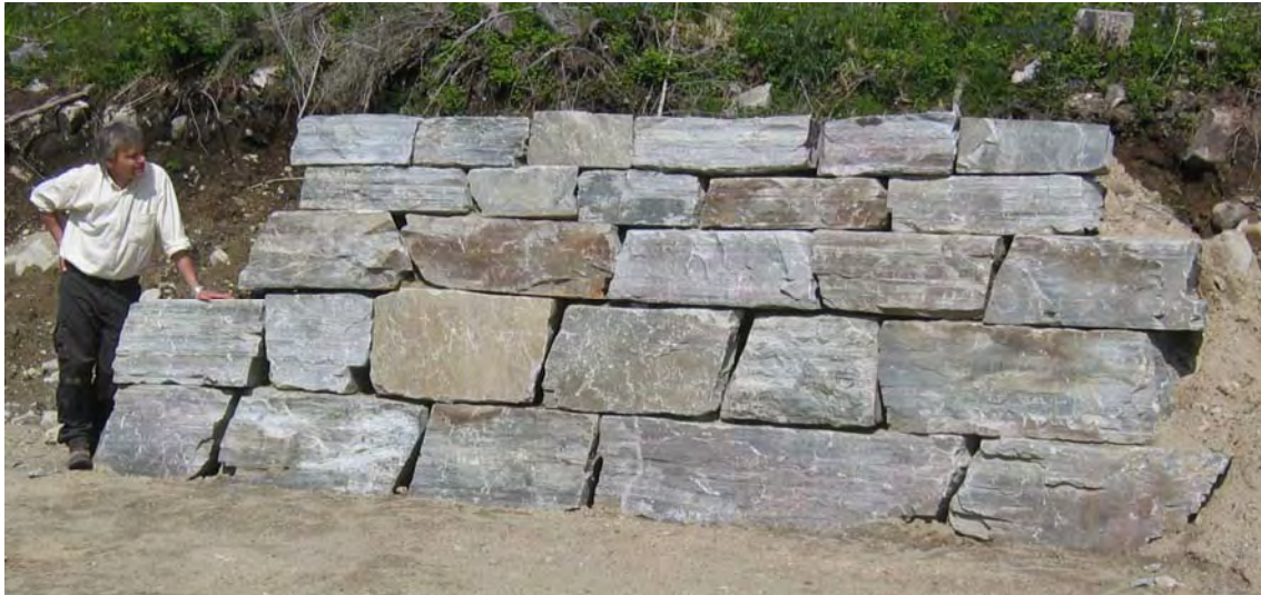
Figur 6: Eksempel på tørrmuring med grovblokk. Ved Grasbottbruddet.
