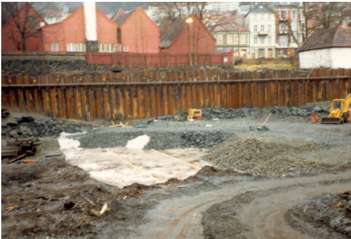
Figur 19 Bilde fra etablering av dreneringslag (pukk). Kilde: Riksantikvaren.
