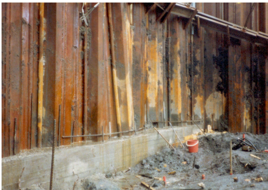
Figur 21 Sprengningsarbeid og antatt tetteforsøk.
