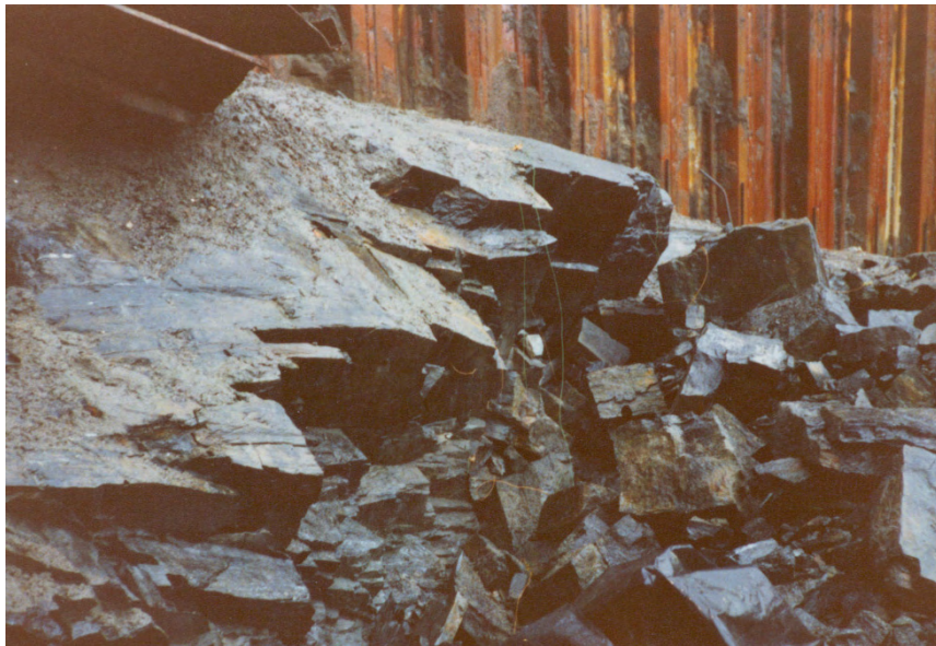
Figur 20 Oppknusing av fjell innenfor byggegrop.
