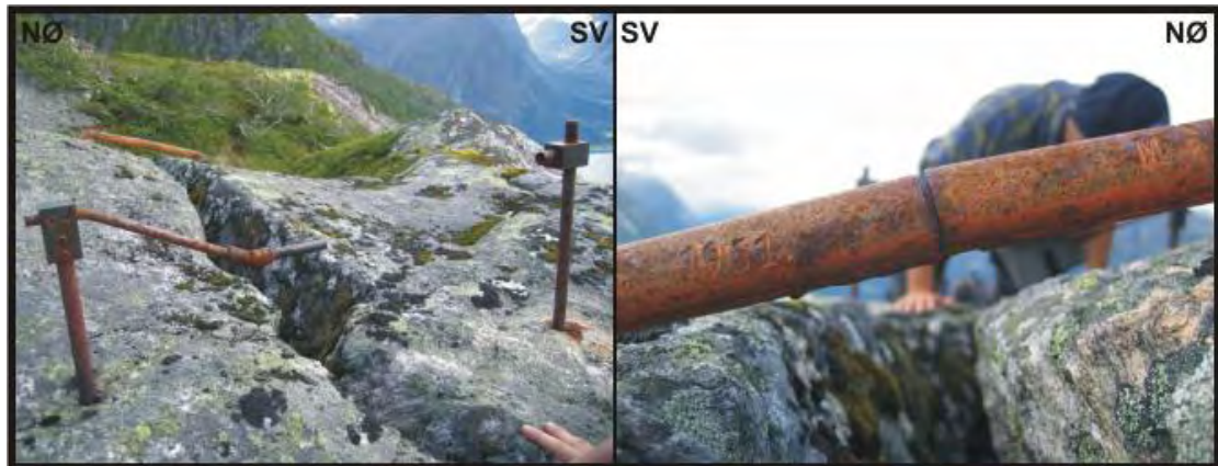
Figur 26: Gamle jernbolter for måling av bevegelse på sprekken i bakkanten av Blokk A. Til venstre- den vestligste bolt er ødelagt. Til høyre- den østligste bolten viser ingen bevegelse, selv om den var satt opp i 1951.
