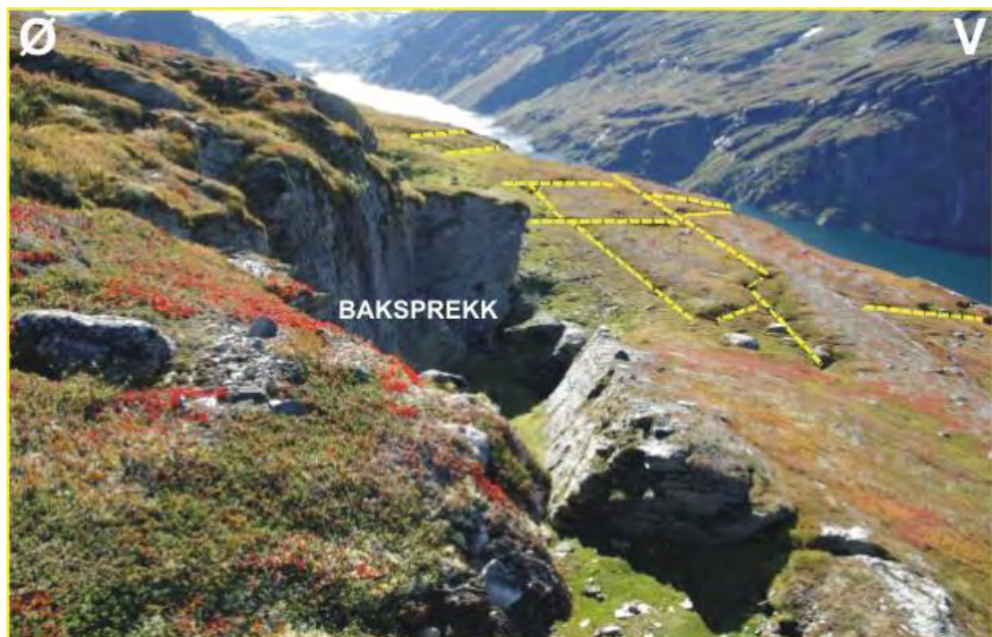
Figur 16: Oversiktsbildet fra helikopter som viser baksprekken, den delvis utløste blokken og de to sprekkeretningene som deler blokken opp i mindre blokker.
