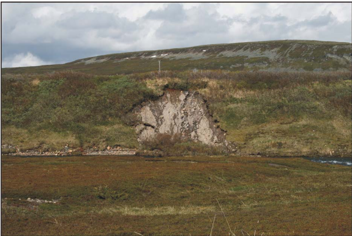
Fig. 4. Grunn utglidning i elveskrent på oversiden av brua over Komagelva.
