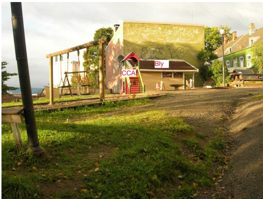
Figur 4.11.2 CCA- impregnerte kantstokker og blyholdig maling.
