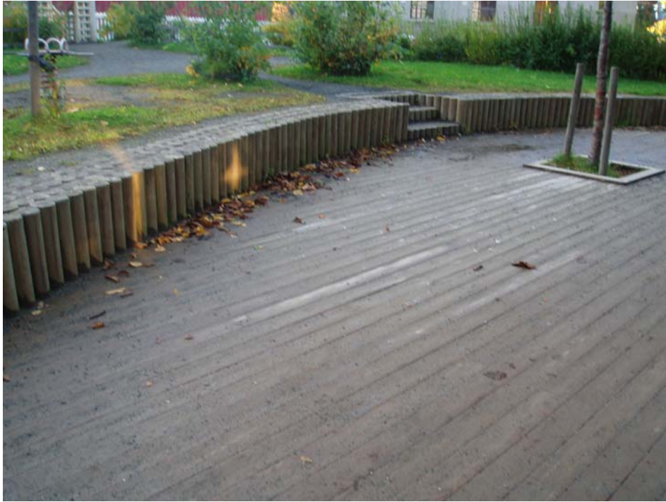
Figur 4.3.1 Platting med CCA- impregnert trevirke.
