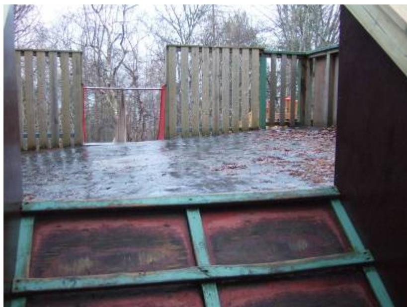
Figur 4.2.1 Tjærelagt tak på "redskapshus" er kilden til PAH-forurensningen i jorda i Spannet barnehage.
