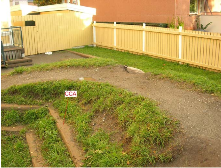
Figur 4.11.3 CCA- impregnert trevirke i amfi
