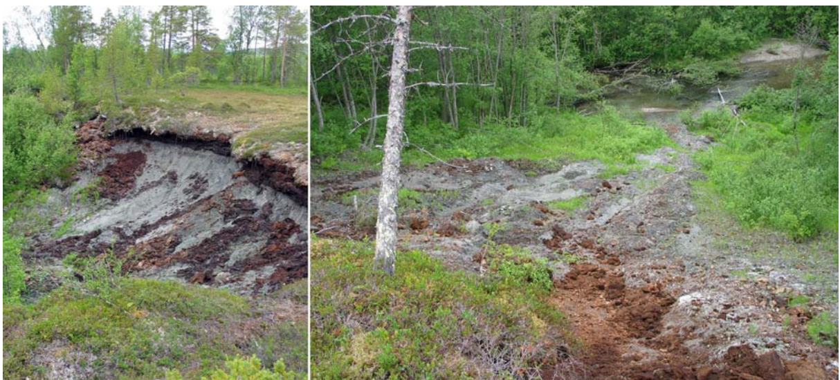
Figur 6. Grunne utglidninger i leire under myr langs Tømmerelva. A) sett fra siden og B) sett fra toppen og ned mot elven.
