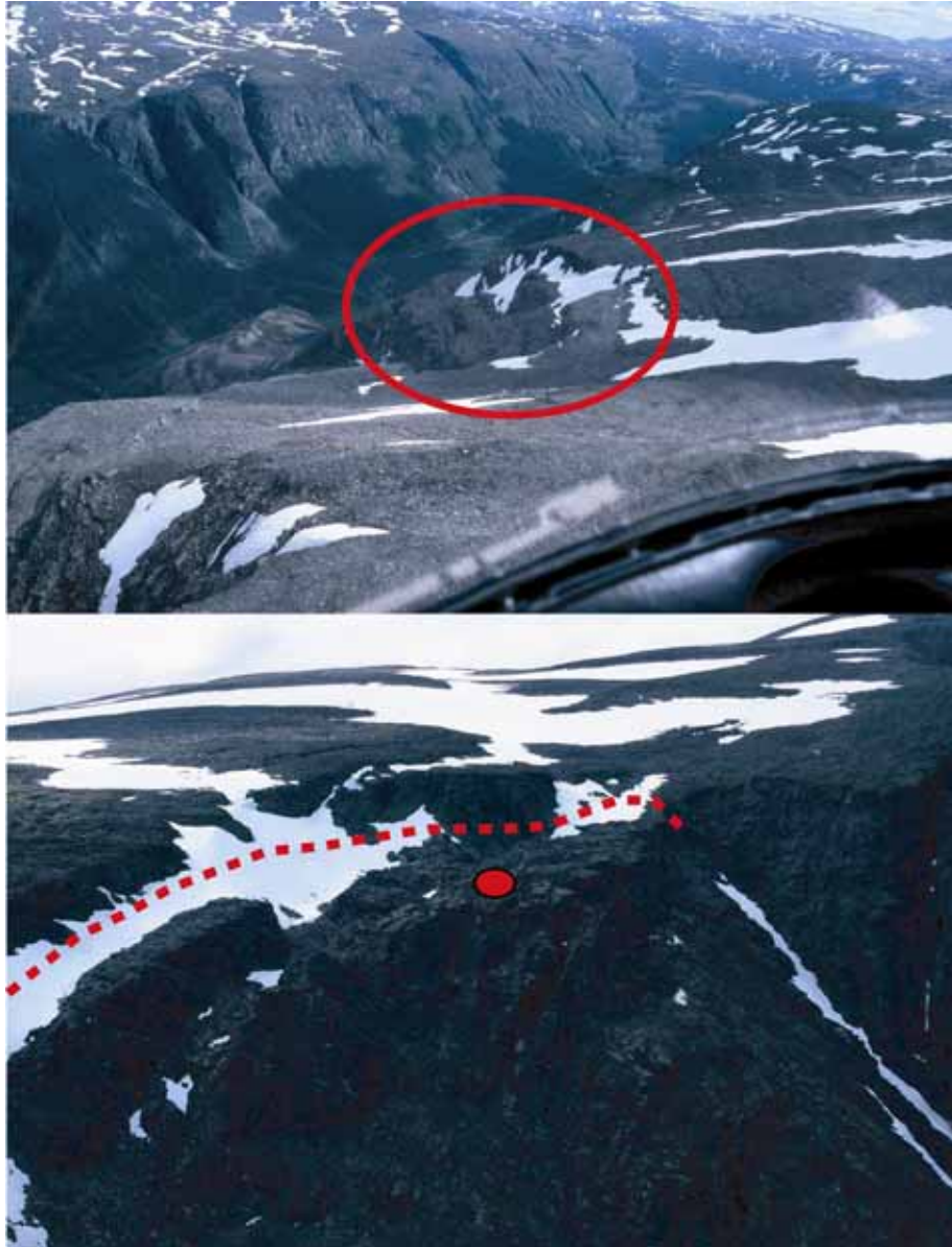
Figur 51. Oversikt over det ustabile fjellpartiet på vestsiden av Kåfjorddalen, sør for Oksfjellet (Kåfjord 2, se Figur 42). Den stipla røde linja viser bakkanten av utglidningen. Den røde sirkelen viser lokalisering av GPS punkt.
