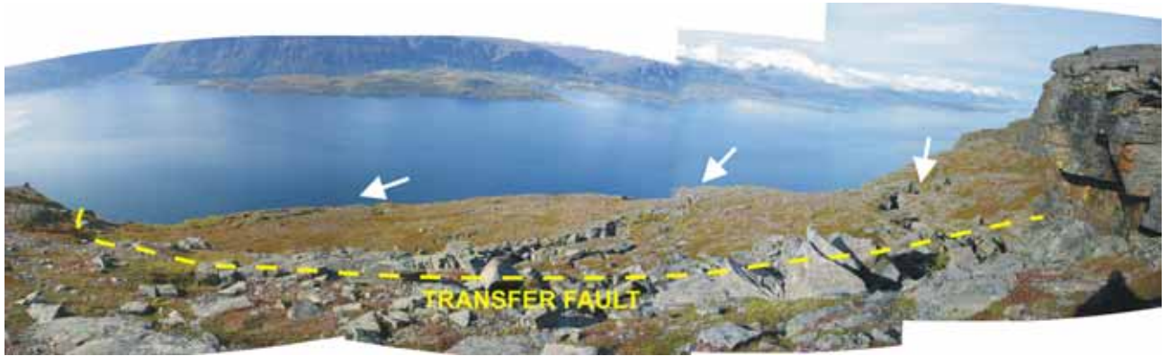
Figur 35. Fotomontasje av Revdalsfjellet som viser de forskjellige kritiske strukturer. Fire store strekksprekker er observert med en lengde på mer enn 100 m. Utgående av disse er markert med hvite piler. Disse har et horisontalt strekk på flere meter og dybden på flere titalls meter.
