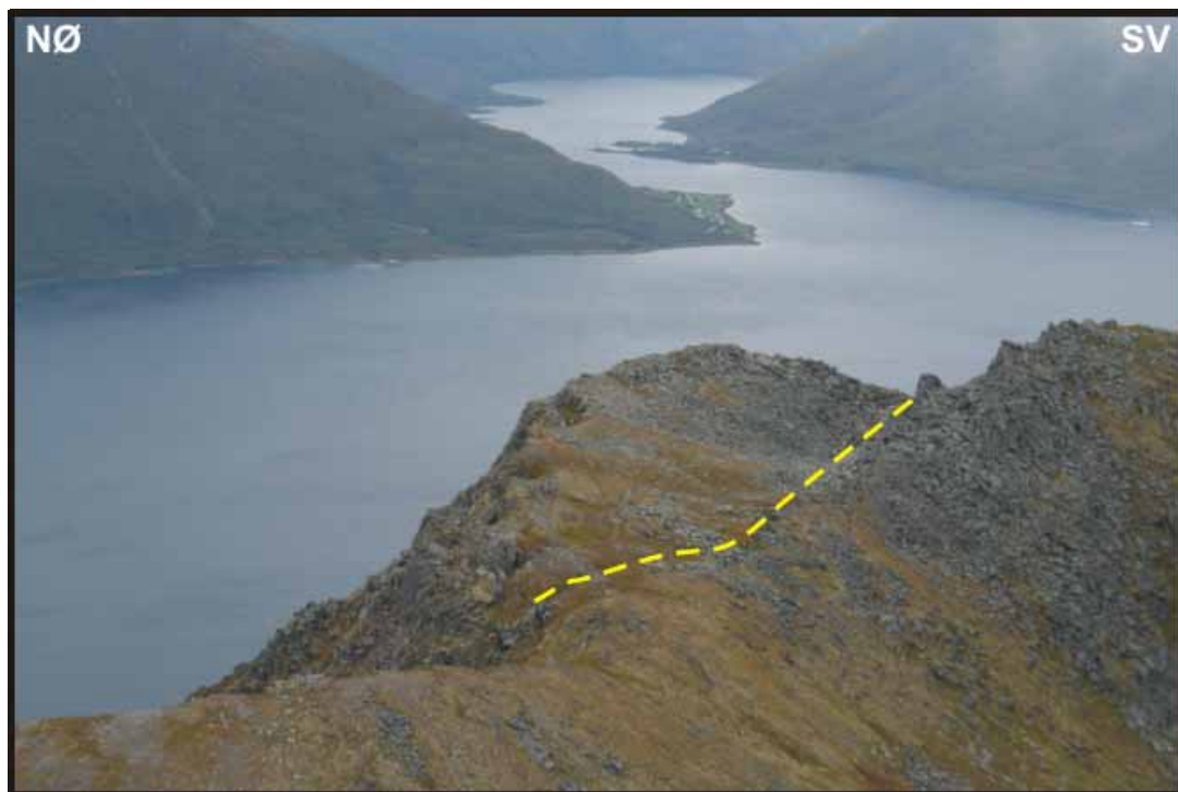
Figur 92. Det sørlige fjellpartiet vist i Figur 90. Den gule linjen viser den baksprekken eller depresjonen som er bak blokken (vist allerede i Figur 90 og Figur 91).
