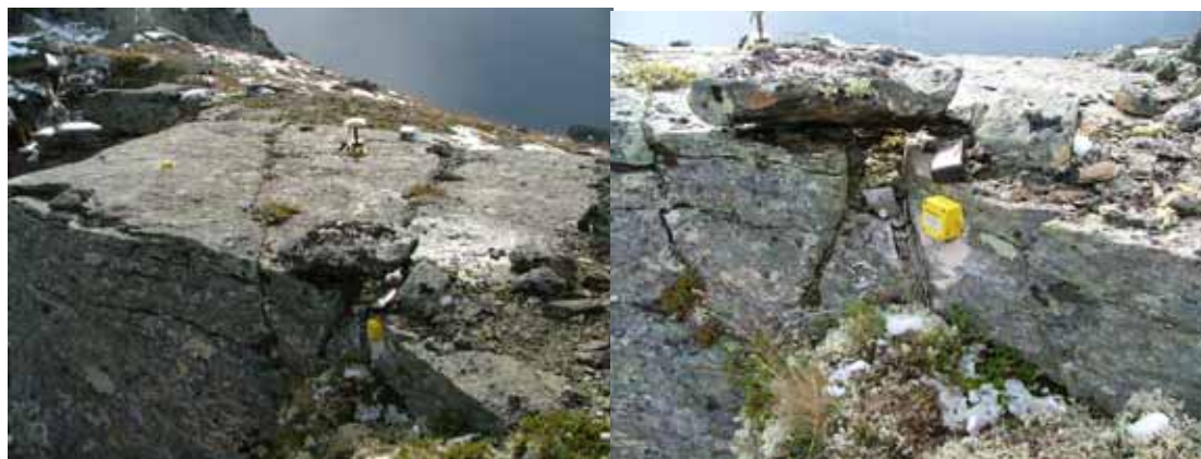
Figur 4. Venstre foto: To sjokk loggere (gul boks) på sida av en aktiv sprekk på Nordnesfjellet. GPS antennen ses montert på GPS målepunktet på samme fjellblokk. Høyre foto: Gul sjokk logger montert på siden av sprekken. Begge bilder er fra 14 september 2005.
