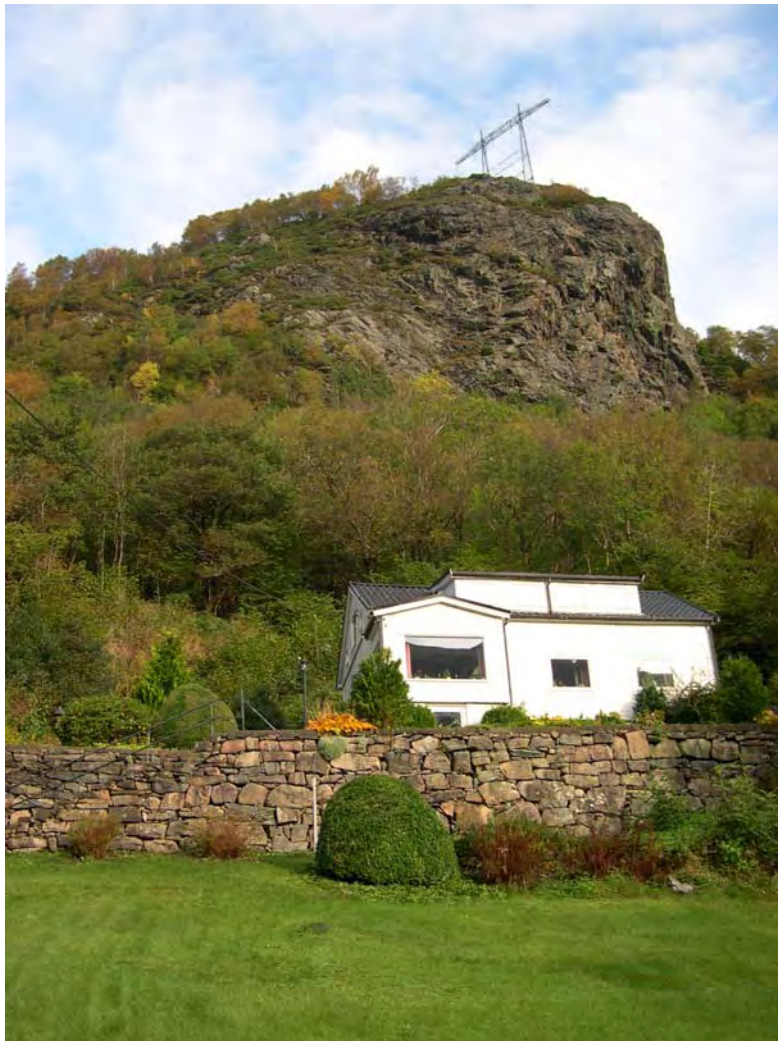
Foto: Høy bergskrent bak huset i Jordalsveien 161 med utraste blokker kamouflert i buskaset nedenfor skrenten.
