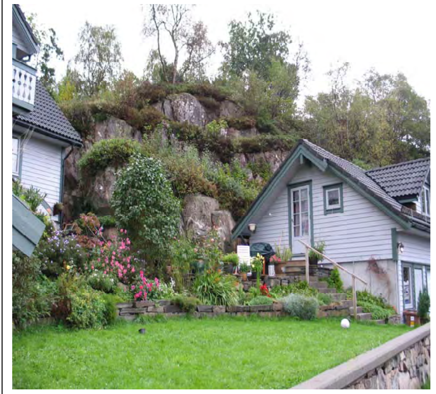
Foto: Buskavegen 40 er anlagt helt inn til fjellveggen. Noe løst fjell sees.
