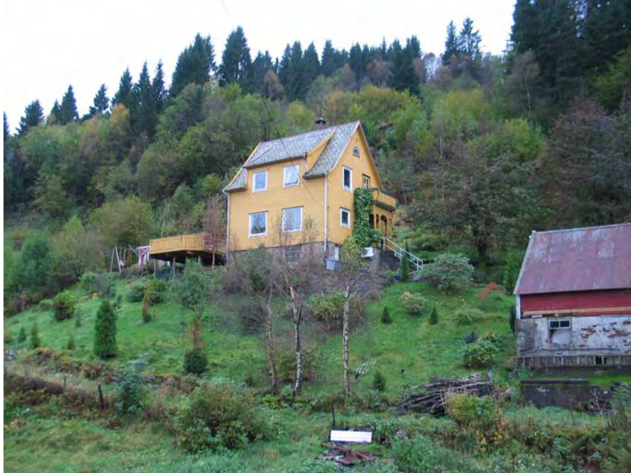
Foto: Kalihaugen 50 med skråningen bak.
