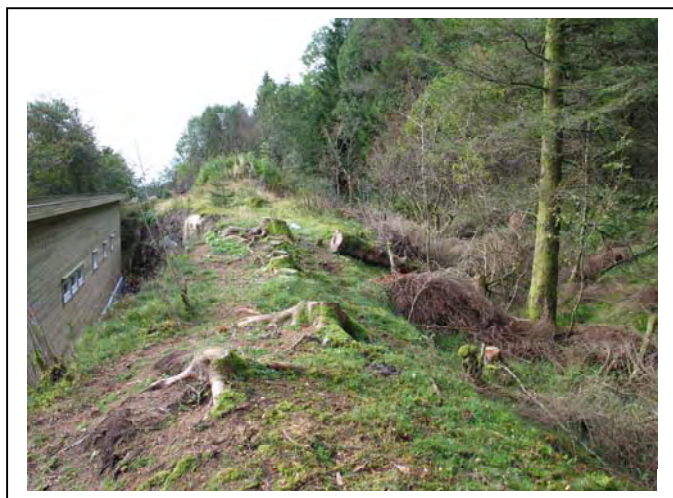
Foto: Nyoppført generasjonsbolig med en naturlig blokkfanger (skiferrygg) for steinsprang fra fjellskråning til høyre.
