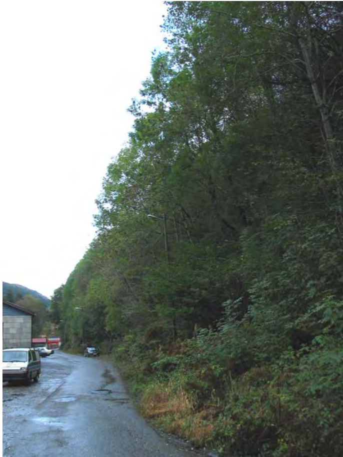
Foto: Skråningen over bilforretningene i Helldalshaugen 12.
