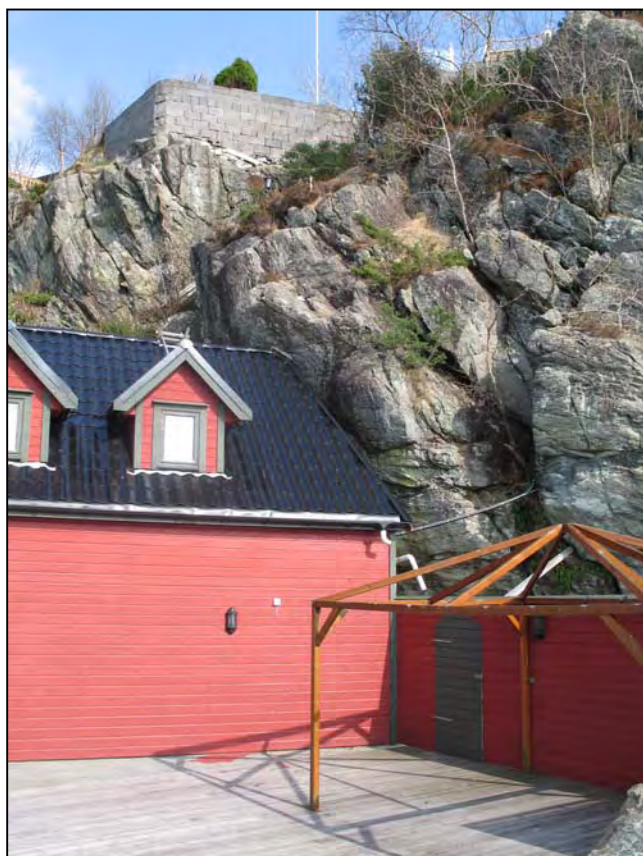
Foto: Oppsprukket fjellframspring bak naust/fritidsbolig ved Kvituren 138.
