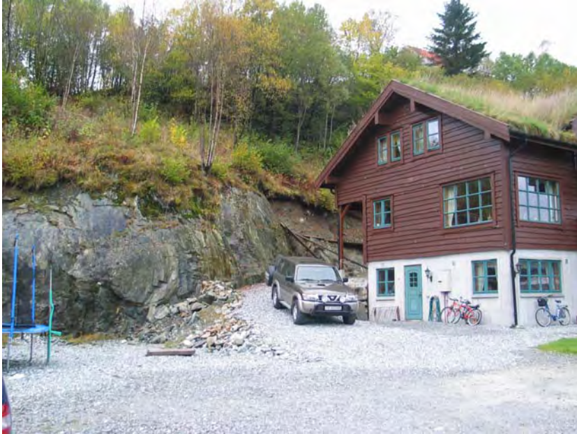
Foto: Løsmasseskråning bak Lonaleitet 147.
