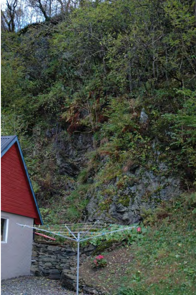
Foto: Helldalsneset 16 med bratt fjellskrent bak garasjen.
