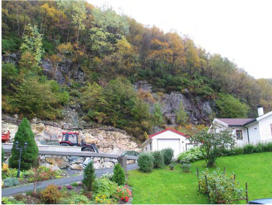
Foto: Skrent brattere enn 45° bak Gullfjellveien 217.
