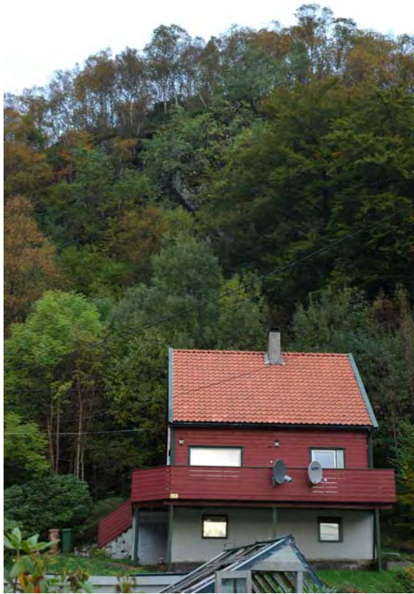
Foto: Hardangerveien 268 under bratt skrent.
