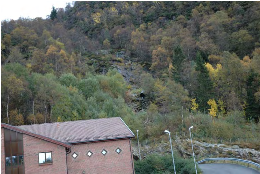
Foto: Sødalen vannbehandlingsanlegg, Sødalsvingene 99.
