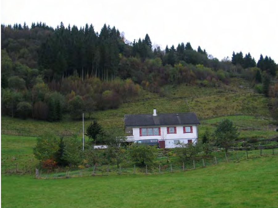
Foto: Løsmasser i bratt skråning bak Kalihaugen 110.
