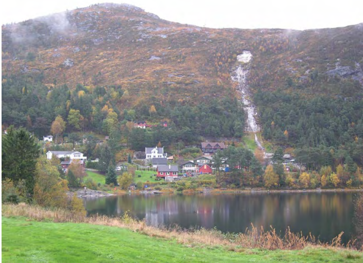
Foto: Jordskred rammet Hetlebakkvn. 115 høsten 2005. Fjellsiden ved skredbanen har et tynt jorddekke av forvittringsjord, løssprengte steiner og torvjord (organisk materiale).
