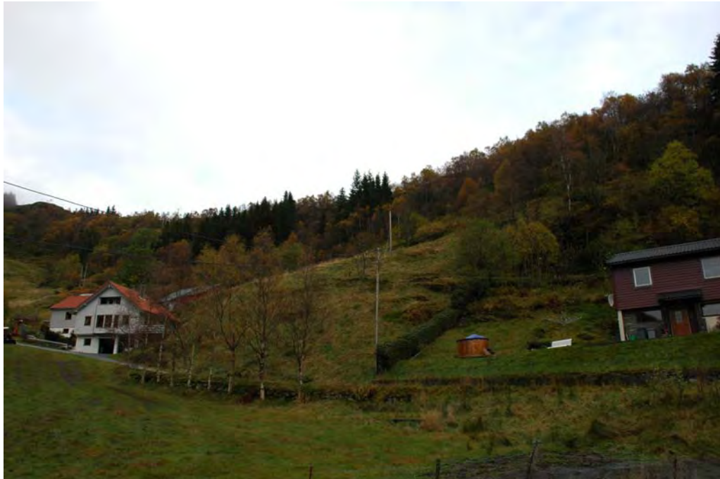
Foto: Skråningen bak Gullfjellveien 424, 426 og 428.
