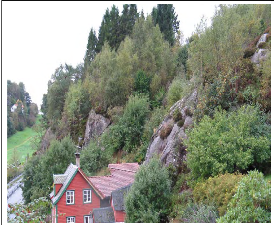
Foto: Krokeidevegen 565 er lagt helt inn til fjellsiden vest for Krokeidevegen. I søkket bak huset er det noe løsmasser.
