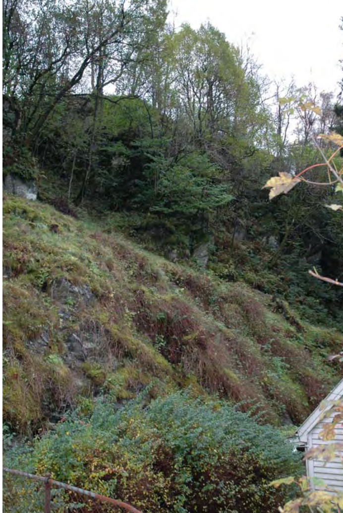
Foto: Bratt skråning bak Dyngelandsvegen 196.
