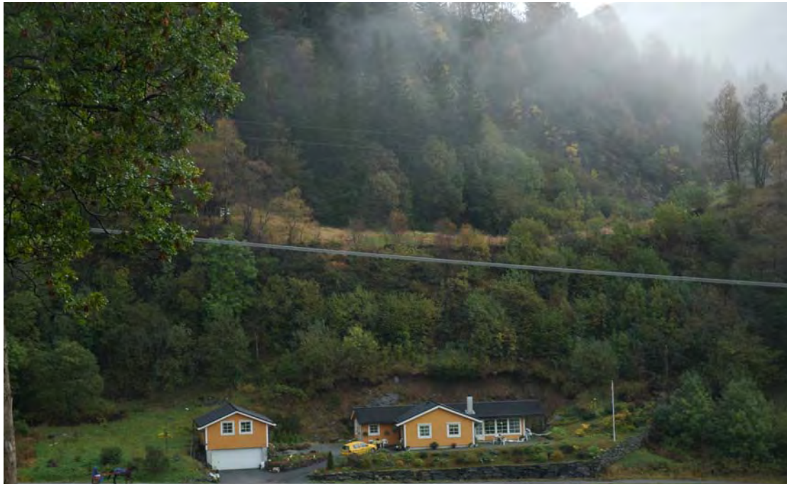
Foto: Skjæring i løsmassene bak Bratlandsvegen 160
