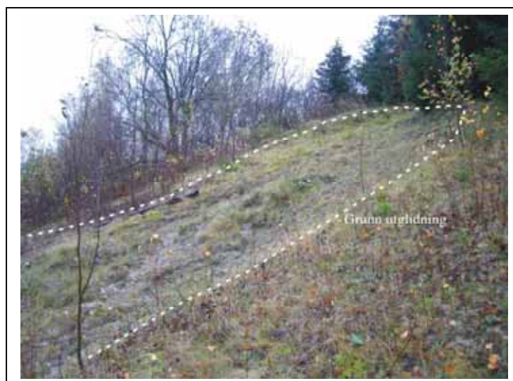
Fig. 5 En grunn utglidning ved Nedre Rælingsveg, Åmot.
