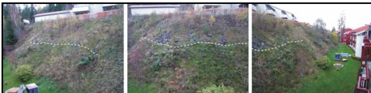
Fig. 15 Skråningen ved Glimmervegen Boligsameie. Stiplet linje markerer kanten på nedglidd materiale.
