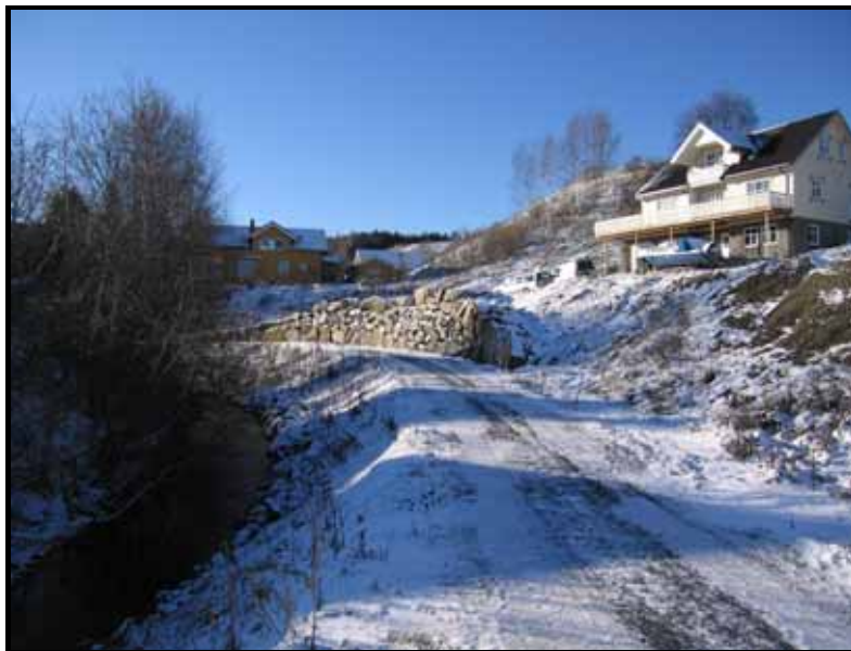
Fig. 18 Forbygning av elven ved veg (Svingen), samt støttemur lagt ved foten av skråning.
