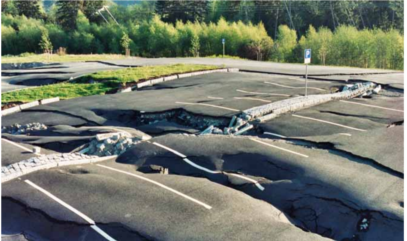
Fig. 28. De store leirområdene omkring Trondheimsfjorden er utsatt for kvikkleireskred. Dette skredet ødela en nylig anlagt parkeringsplass ved E6 i 2002. Store utfyllingsarbeider var blitt utført på den ene siden av en ravine i nærheten. Menneskelig aktivitet er den største enkeltfaktor for utløsning av kvikkleireskred i Norge i dag. Tidligere var elve- og bekkeerosjon den viktigste faktor for utløsning av store skred. Foto: Terje H. Bargel.
