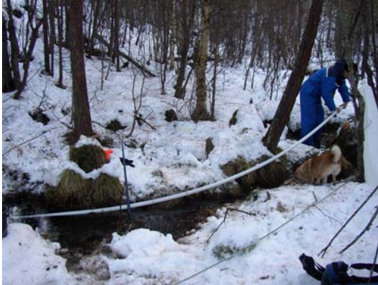
Rørlegging på Dombås.
