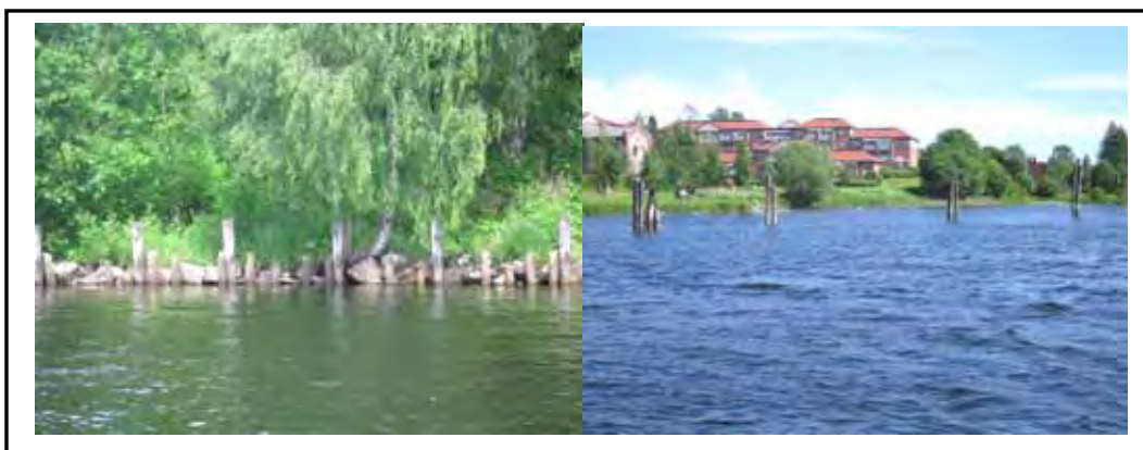
Fig. 21. Elveforbygning og rester av tømmerlenser i Drammenselva.
