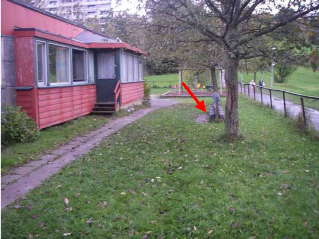
Pilen linjen viser hvor prøve 14 ble tatt.
