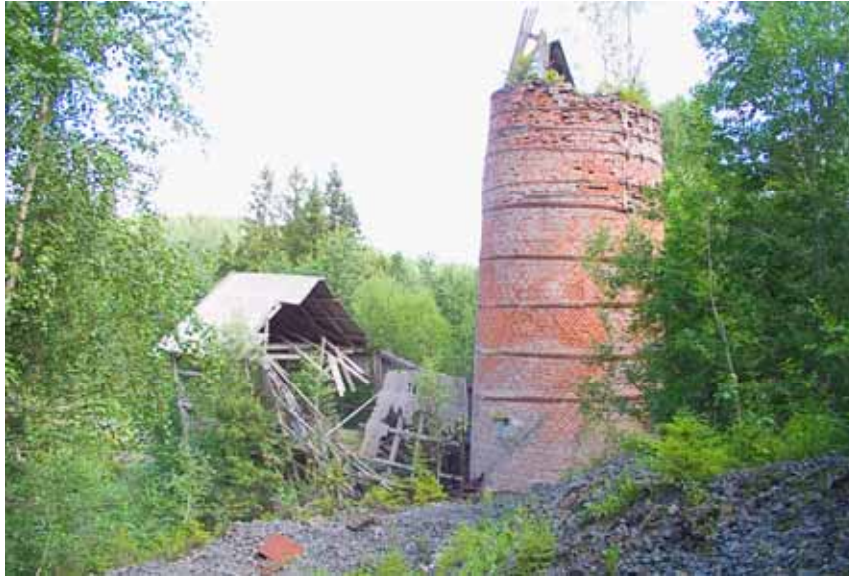
Fig. 18: Den nedlagte kalkovnen ved Hallom kalksteinsbrudd på Roa.
