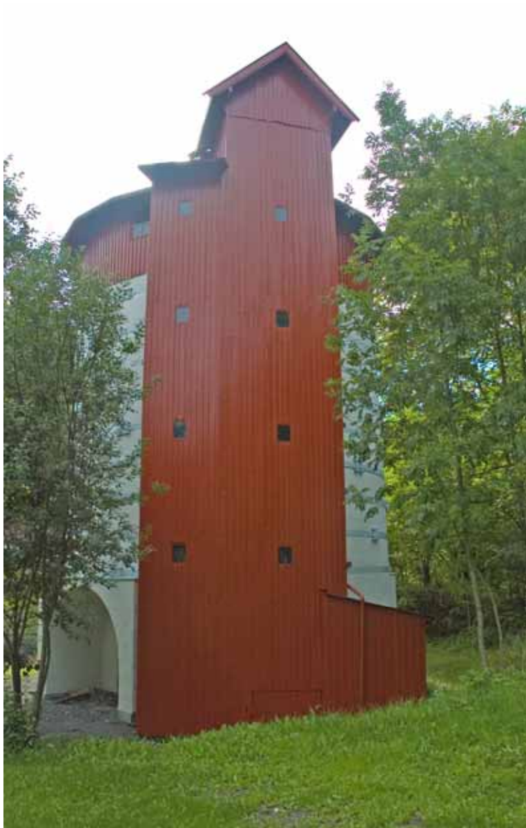
Fig. 2: Ovn for framstilling av brent kalk, ved Spikkestad stasjon, nedlagt i 1940 årene.
