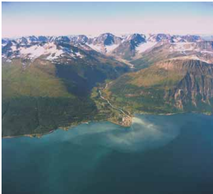
Figur 2. Såret etter fjellskredet fra Pollfjellet i 1810 trer tydelig frem i høyre del av bilde.
