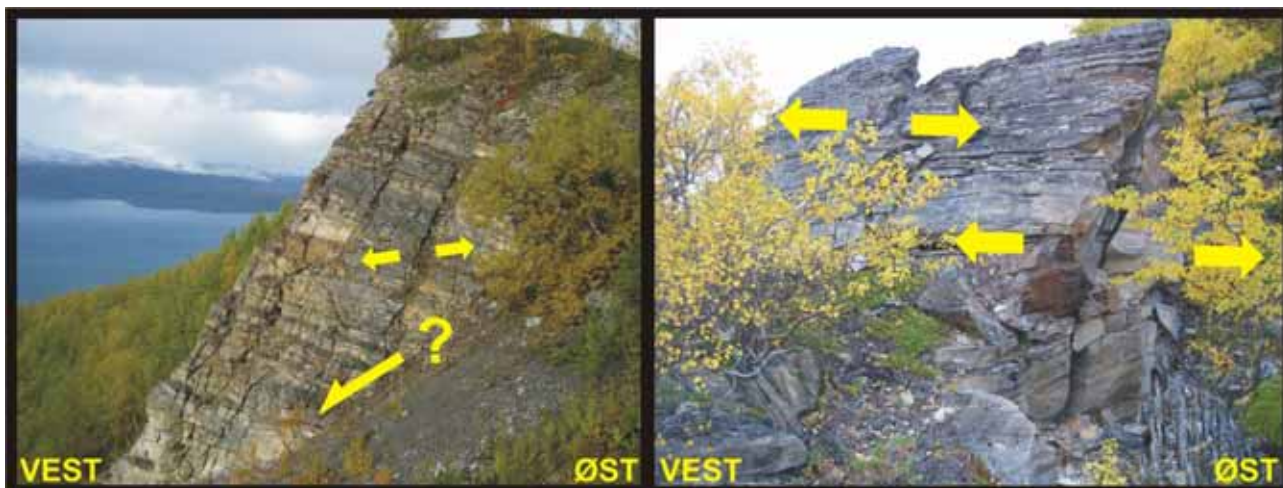
Figur 21. Steiltstående sprekker som er observert i den nedre del av Indre Nordnes. Det er antatt at fjellpartiet beveger seg på et lavvinkla skjærplan.
