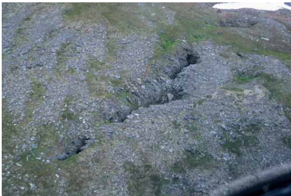
Figur 44. Sprekker i overflaten av det ustabile fjellpartiet vest for Austerfjorden (Figur 39 og Figur 43)
