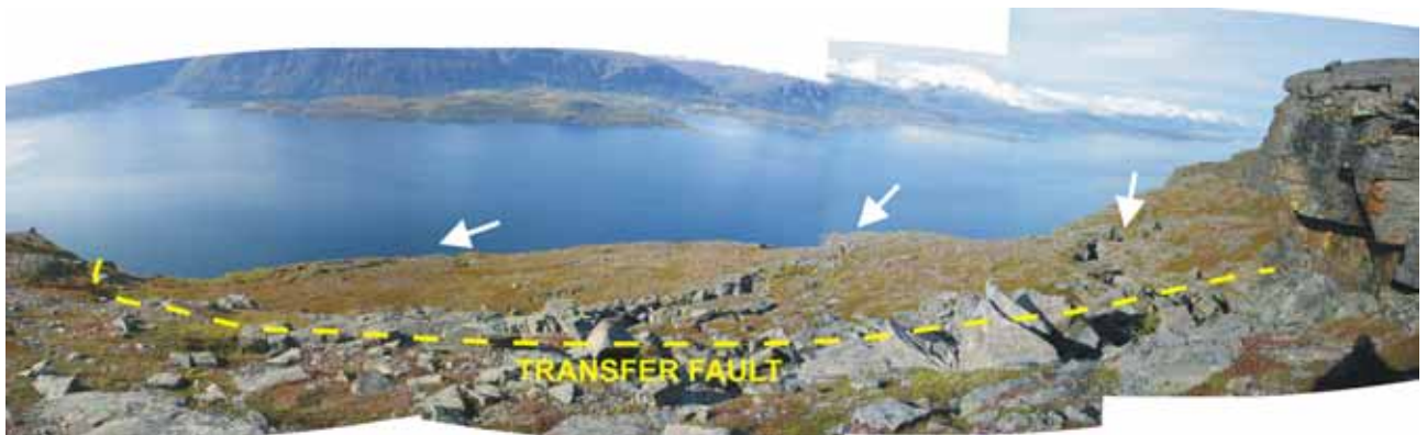
Figur 25. Fotomontasje av Revdalsfjellet som viser de forskjellige kritiske strukturer. Fire store strekksprekker er observert med en lengde på mer enn 100 m. Utgående av disse er markert med hvite piler. Disse har et horisontalt strekk på flere meter og dyp på flere titalls meter.
