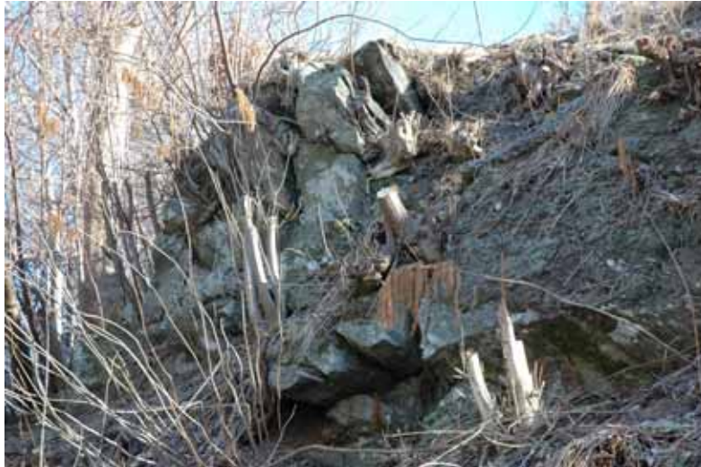
Foto: Oppsprukket fjell ved Statminister Michelsensvei 69B
