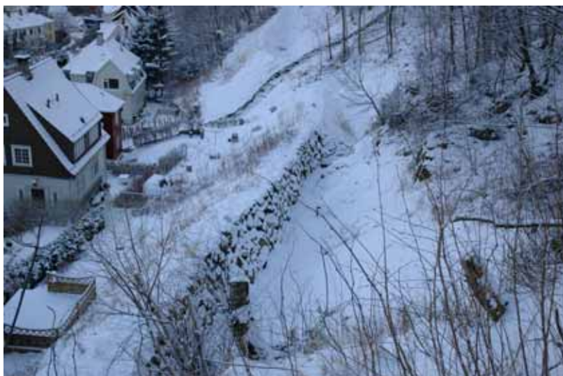
Foto: Sikringene med voll for Bjørndalen 42-36
