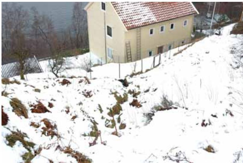
Foto: Løsmasseskråning ved Tellevikveien 81.
