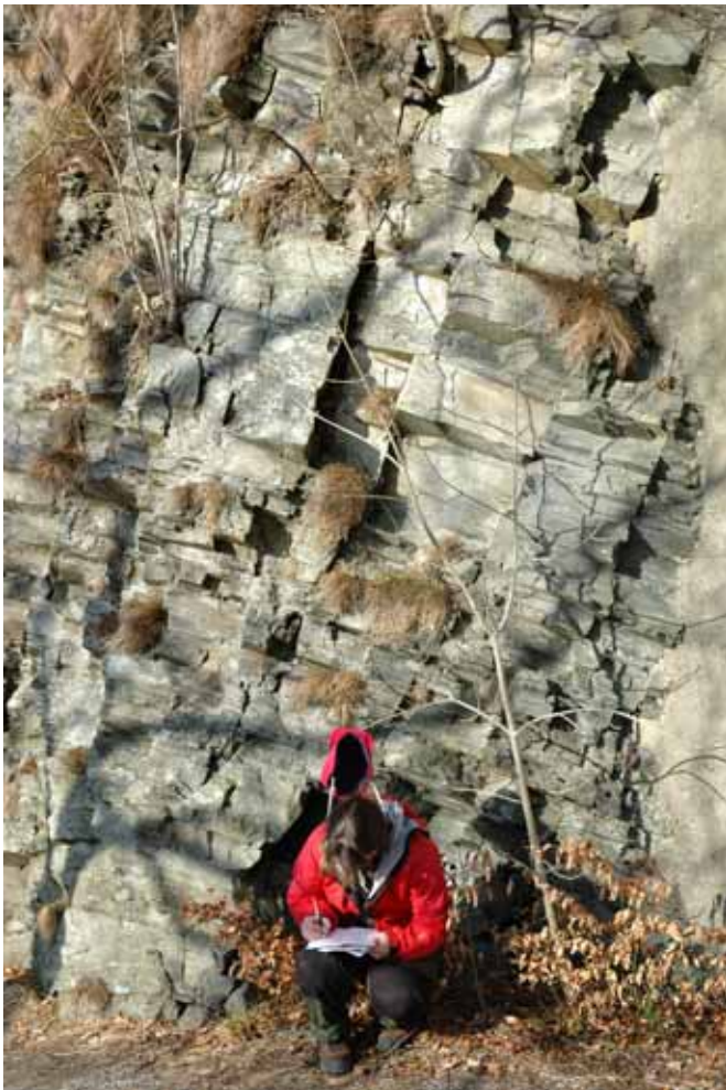
Foto: Sprekker i fjell ved Vognstølen.
