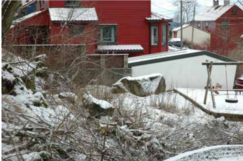
Foto: Skråningen mellom Kolstien 77 og 73. Blokk helt ned mot lekepass ved nr 73.
