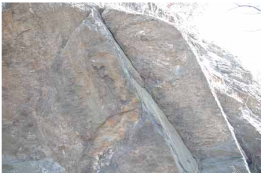
Foto: Oppsprukket fjell bak Ny Paradis 86.
