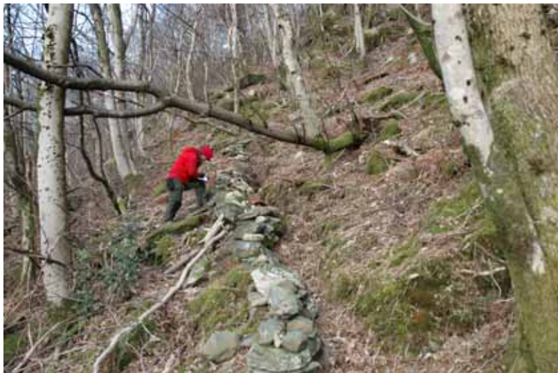
Foto: Dreneringskanal over Øvre Kolstien 28
