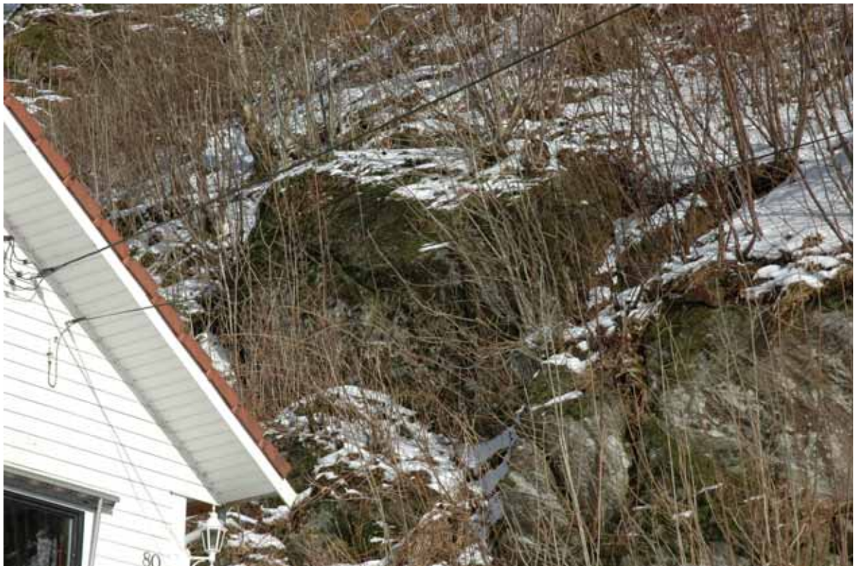
Foto: Skråningen bak Sædalsveien 80.
