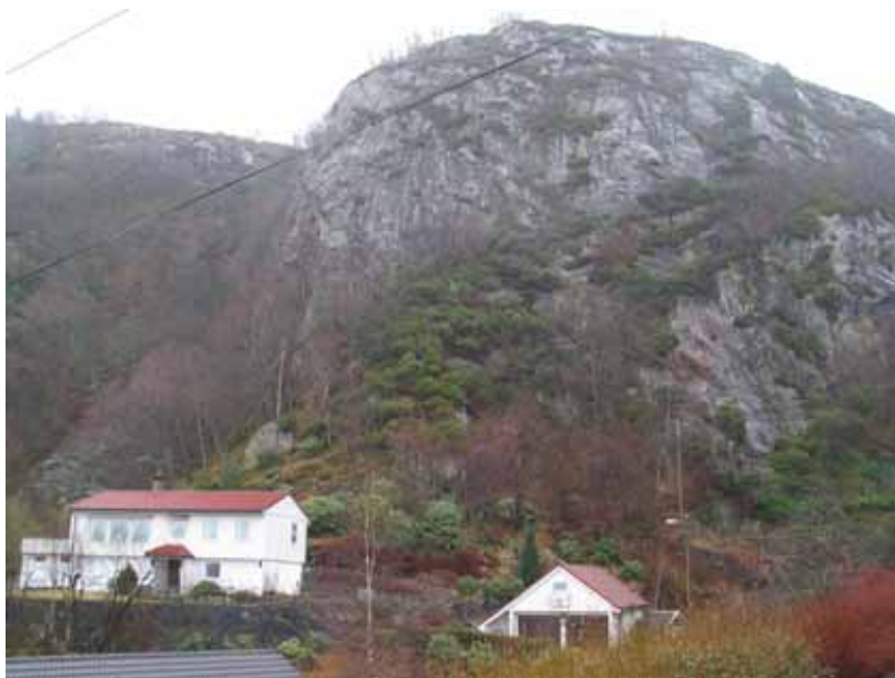
Foto: Stallkleiven. Skredmateriale ligger under skrenten helt ned til boliger.
