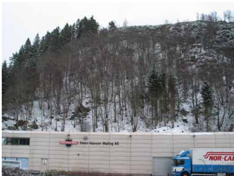
Foto: Steinsprangblokk ligger helt ned til boliger og næringsbygg i Ullsmågvegen.
