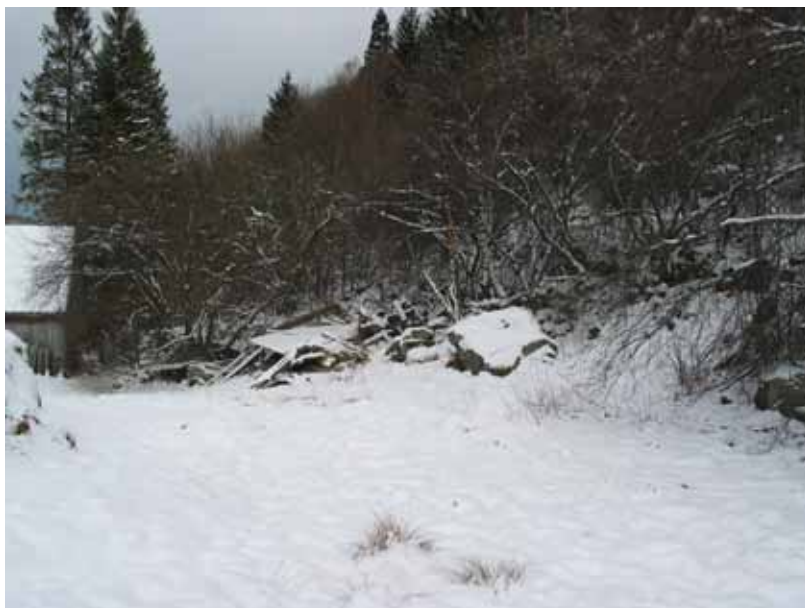
Foto: Skredmateriale ligger helt ned til dyrket mark og driftsbygning
