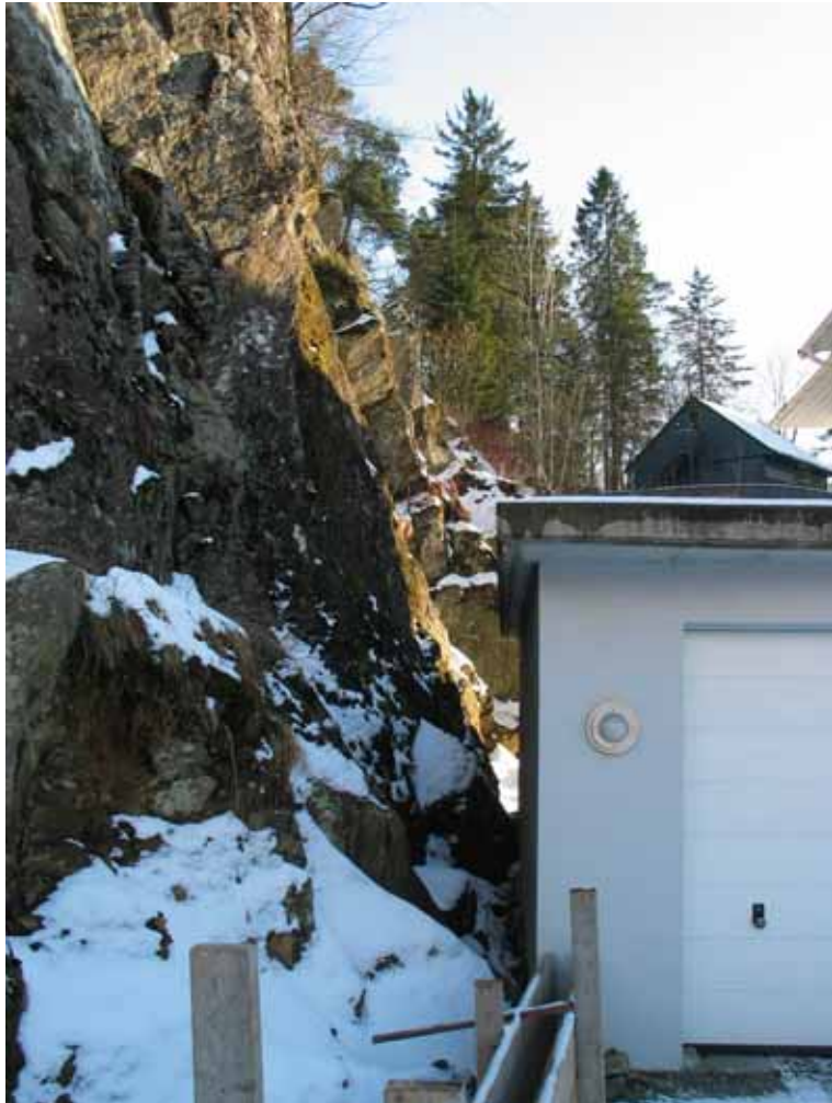
Foto: Gunvors veg 8. Tilsynelatende løs blokk i fjellveggen svært nær boligen
