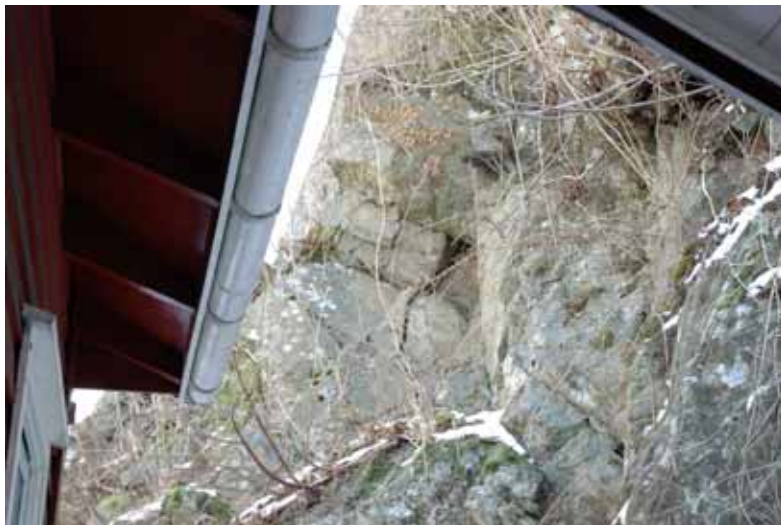
Foto: Oppsprukket fjell bak Statminister Michelsensvei 70
