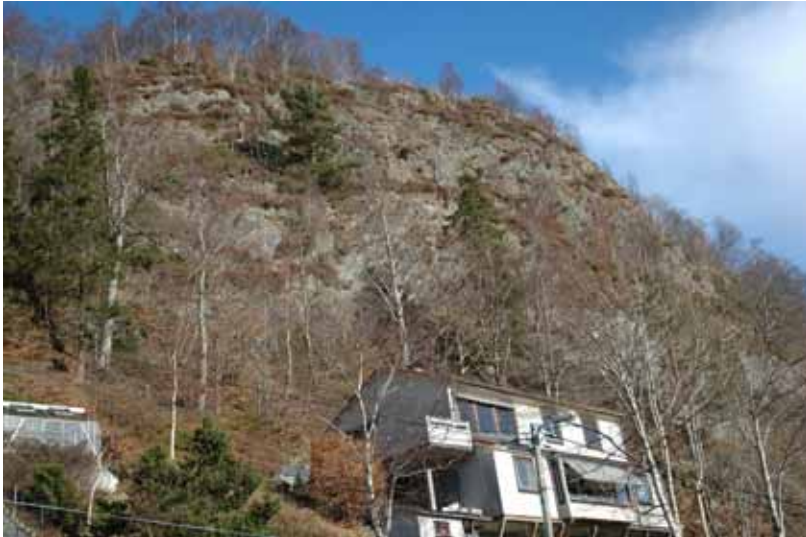
Foto: Vognstølen 16J under bratt fjellskrent.
