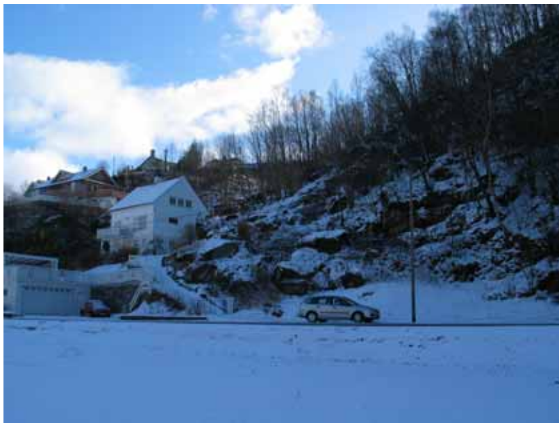
Foto: Skredblokker ligger helt ned til vegen ved Sanddalsvegen 27.
