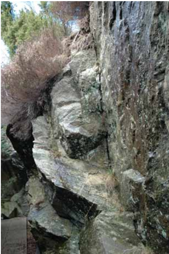
Foto: Oppsprekking i fjellskrenten ved Djupedalen 21.
