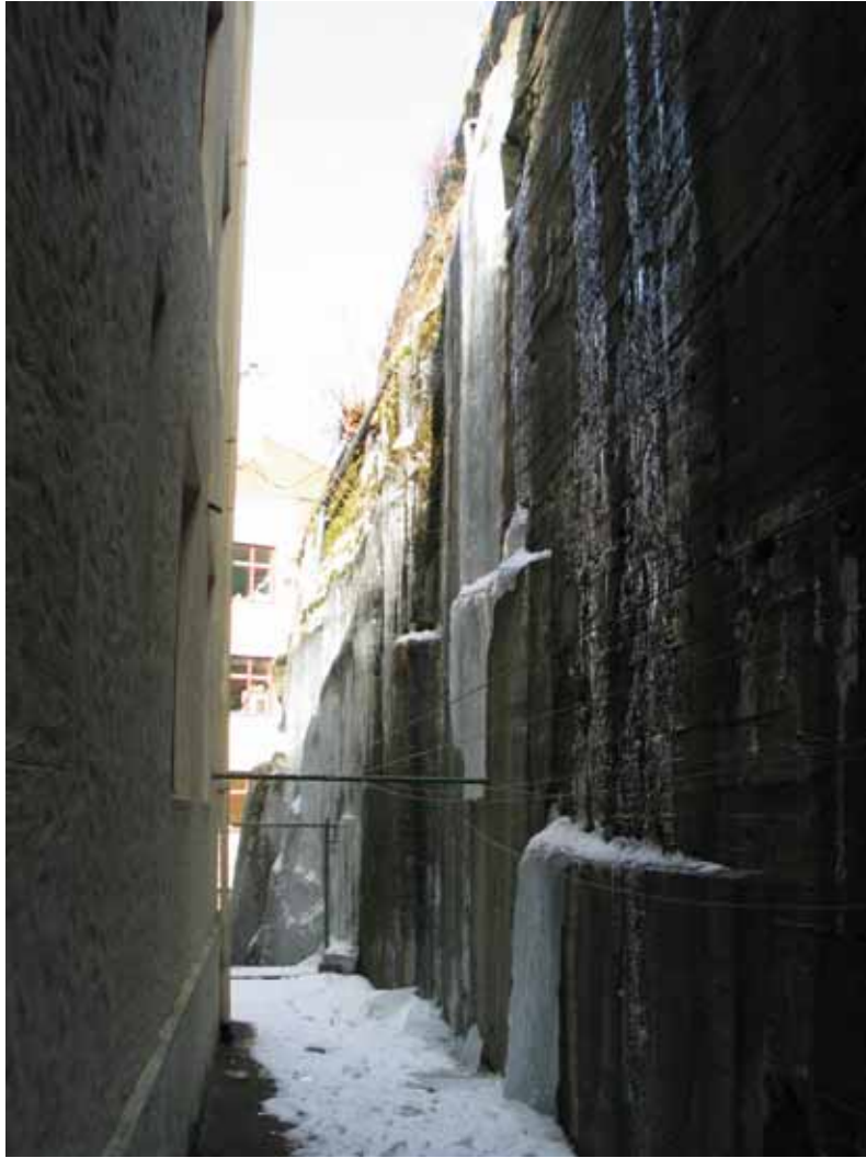
Foto: Helstøpt støttemur bak Sophus Pihls gage 14. Foto BaF.
