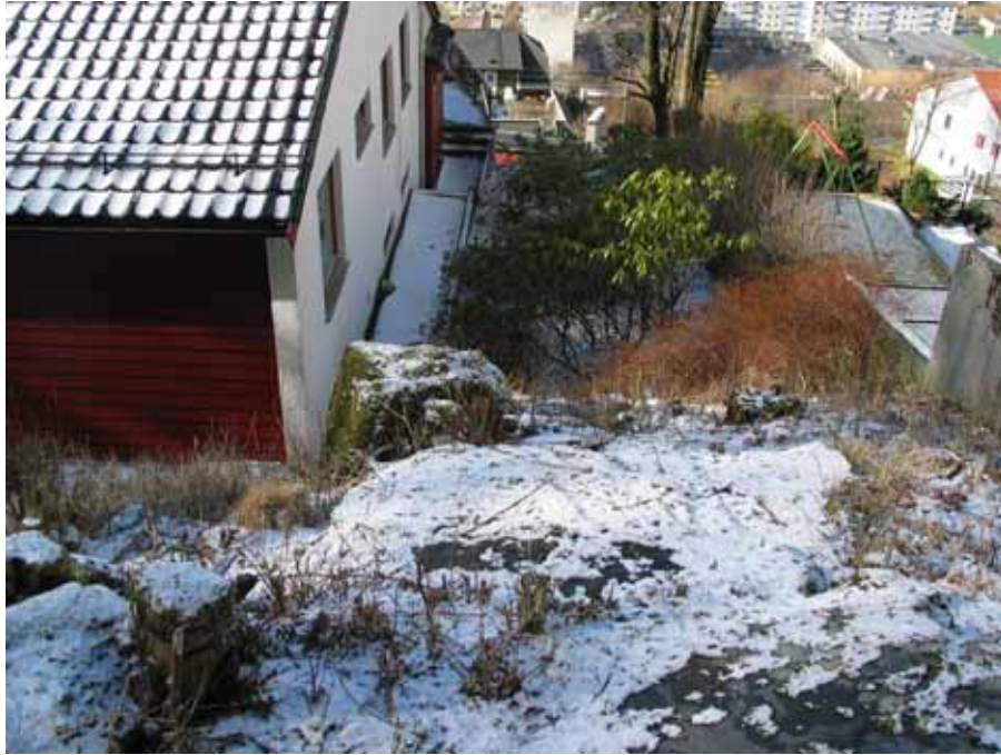
Foto: Steinsprangblokk helt ned til husveggen ved Kolstien 43E.
