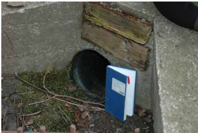
Foto: Drenering ved Nattlandsveien 98A.
