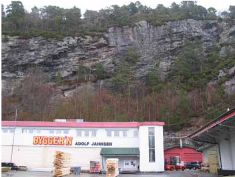
Foto: Næringsbygg under fjellsida ved Helvetesvatnet
