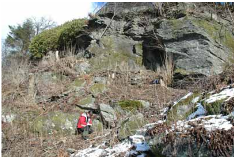
Foto: Overheng og oppsprukket fjell bak Nyhaugslia nr. 19.
