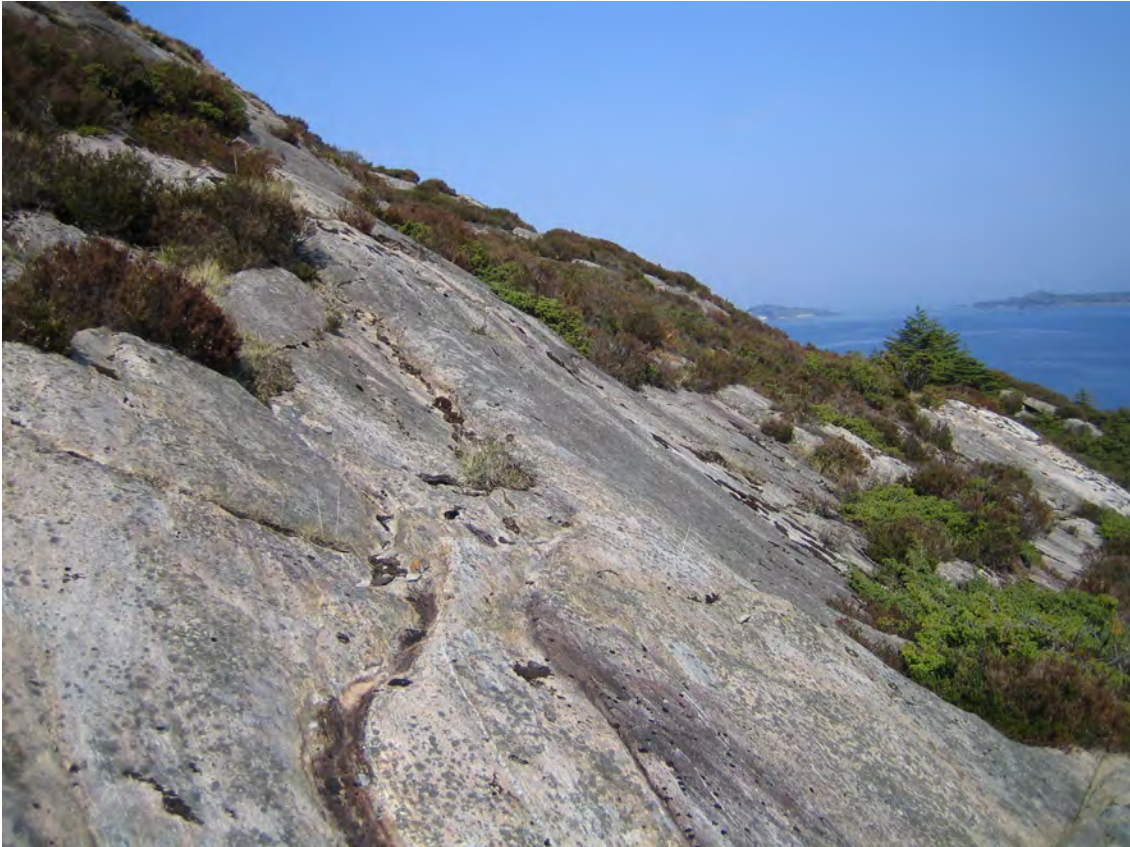
Fig. 7. Øyegneisens foliasjon faller parallelt med terrengets fall i skråningen ned mot fjorden.
