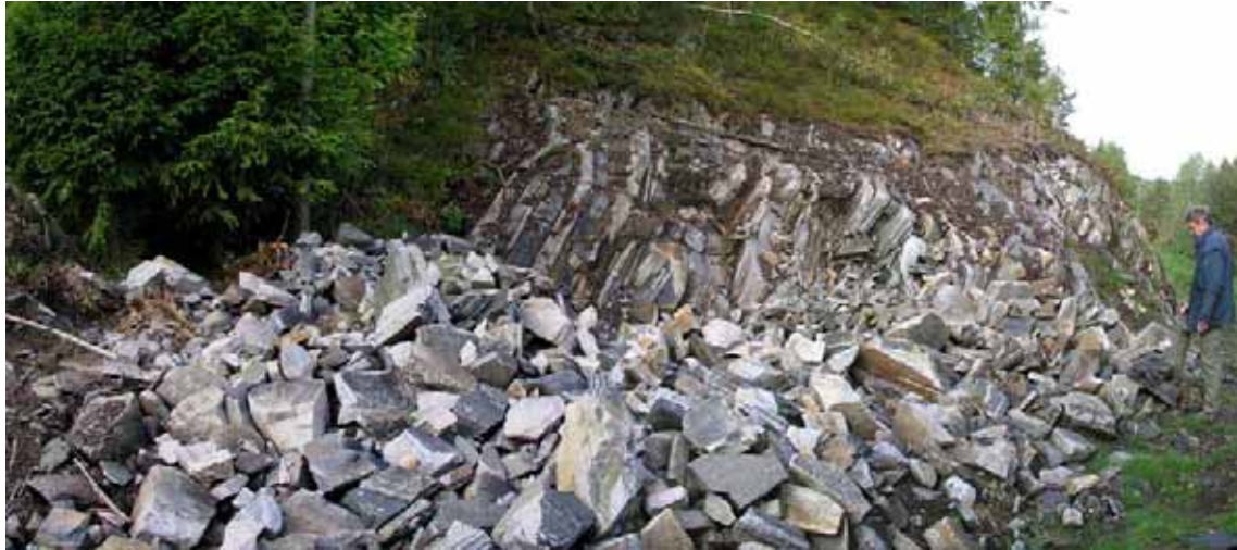
Figur 2 Prøvebrudd ved Lønne gård.
