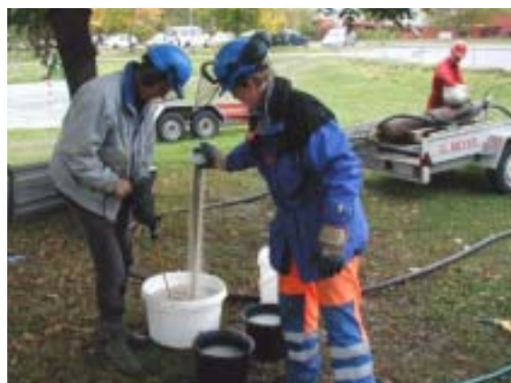
Figur 4–17: Blanding av vann, guar gum og sand. Påfylling av injeksjonsblanding på høytrykkstanken er vist i høyre i bakkant.
