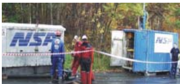
Figur 4-5: Aggregat og container med blander, beholder og injeksjonspumpe.
