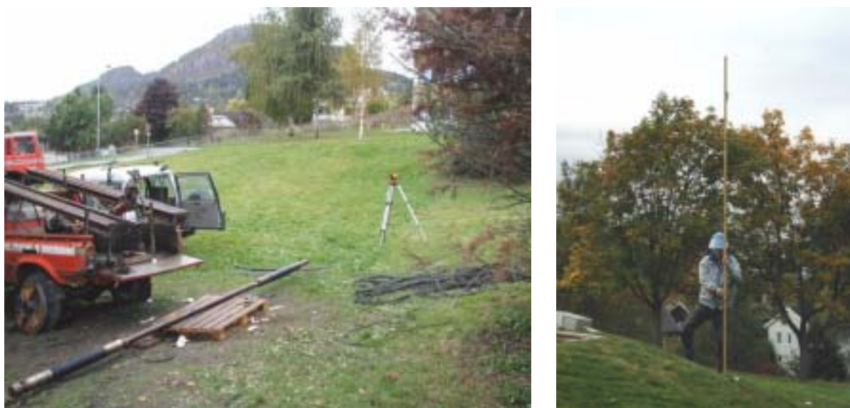
Figur 4–20: Oppsett av nivellerkikkert og måling med nivellerstang.
