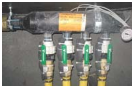
Figur 4–15: Venstre: Strømningsmåler og varmeveksler i VVS-kummen rundt toppen av borehull 3 ved Bryn. Høyre: Samlerør for oppumpet grunnvann fra satellittborehullene. Systemets trykk overvåkes ved hjelp av et analogt manometer, og temperatursensorene er festet med isolasjon og bånd.
