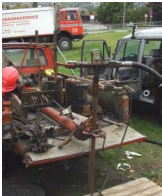
Figure 2–9: Rørtopp for hydraulisk trykking påmontert vannslange fra tankbilen. Hydraulikkslange for måling av vanntrykk er montert under vannslangen.
