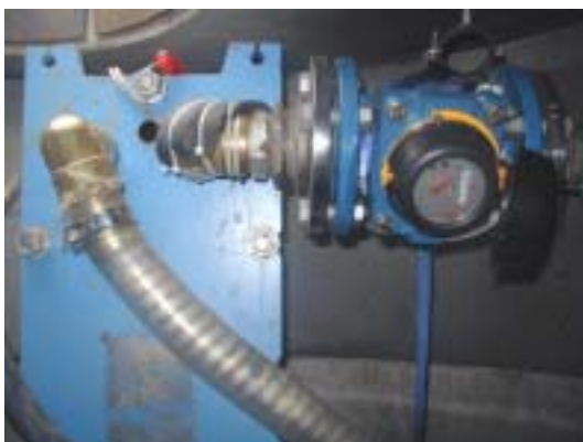
Figur 4–15: Venstre: Strømningsmåler og varmeveksler i VVS-kummen rundt toppen av borehull 3 ved Bryn. Høyre: Samlerør for oppumpet grunnvann fra satellittborehullene. Systemets trykk overvåkes ved hjelp av et analogt manometer, og temperatursensorene er festet med isolasjon og bånd.
